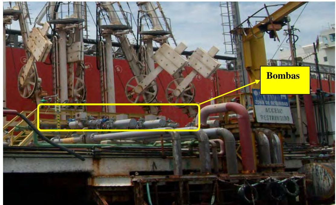
Figura 2.4 Bombas del Muelle “Duque de Alba”.
