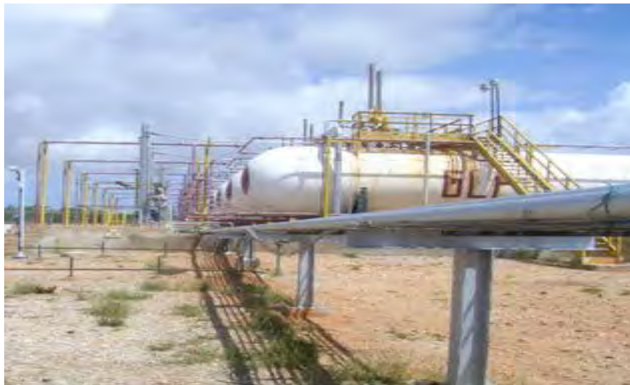
Figura D: tanques de almacenamiento del GLP.
