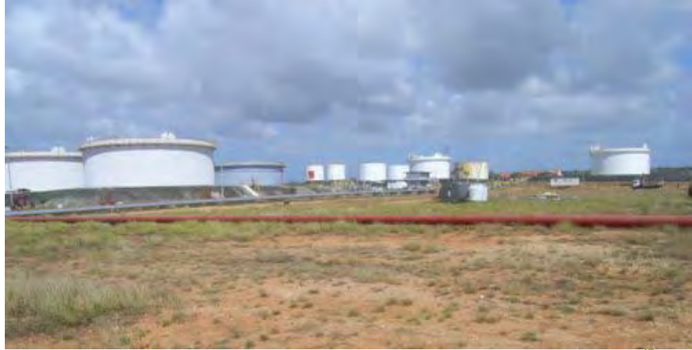
Figura C: tanques almacenadores de la planta PDVSA El Guamache.
