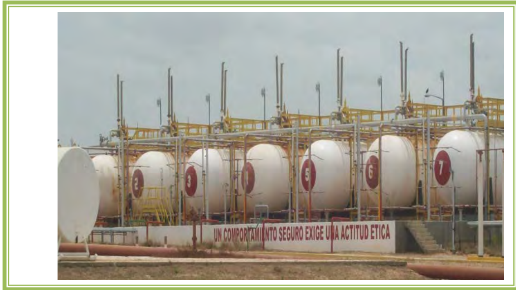
Figura E: tanques de almacenamiento del GLP.
