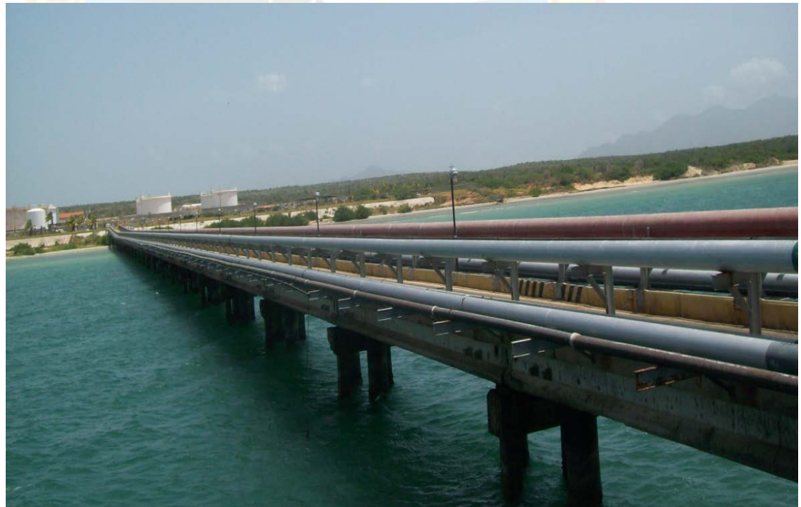
Figura 2.5 Muelle gabarra y la línea de tuberías que transporta los fluidos a sus respectivos tanques.
