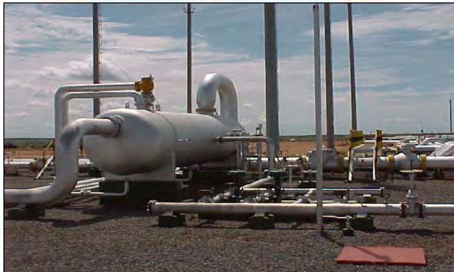
Figura 2.6 Separador Ciclónico Utilizado en la Industria Petrolera
