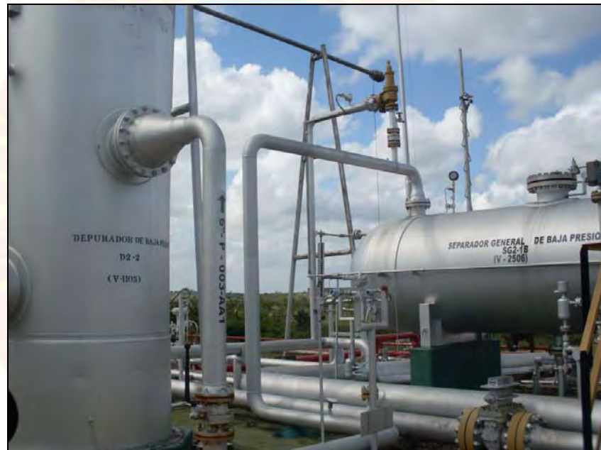
Figura 2.9 Separador general de baja presión Estación de Flujo tres de Orocuai Fuente: www.pdvsaorocual.com
