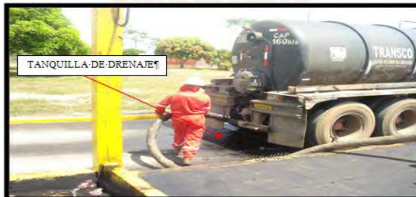
**Figura 4.5 Operaciones de conexión de vaccum**
