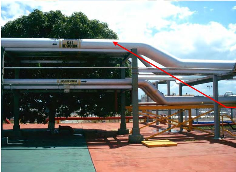
Cabezal de Gas de Succión
