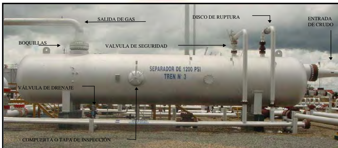
Figura 2.7 Partes Externas de un Separador
