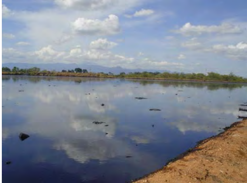
Figura 4.9 Vista Sur de la Macrofosa ORC-1
