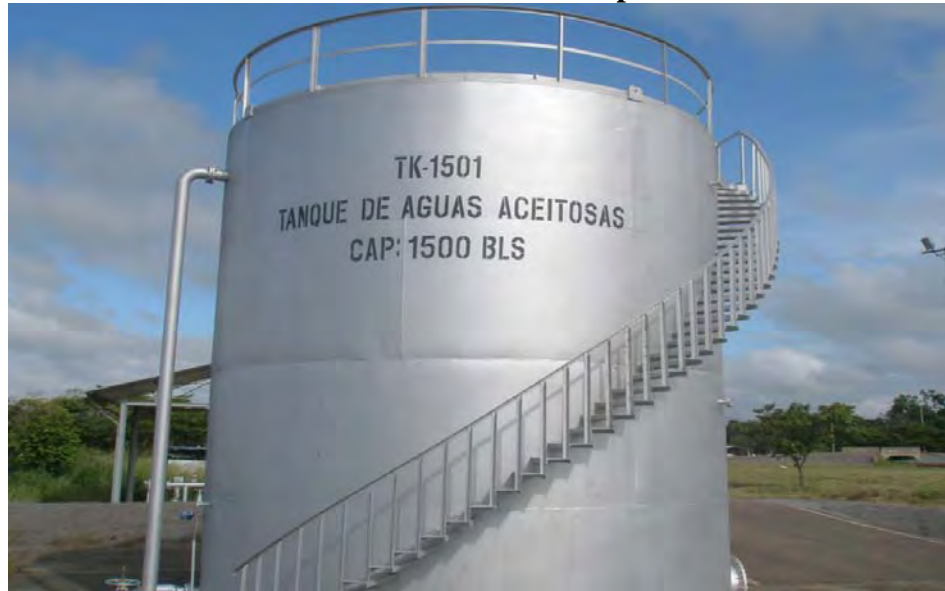
Figura 4.18 Tanque de Estabilización T-1501 para la Recolección de las Aguas Aceitosas de las Plantas Compresoras
