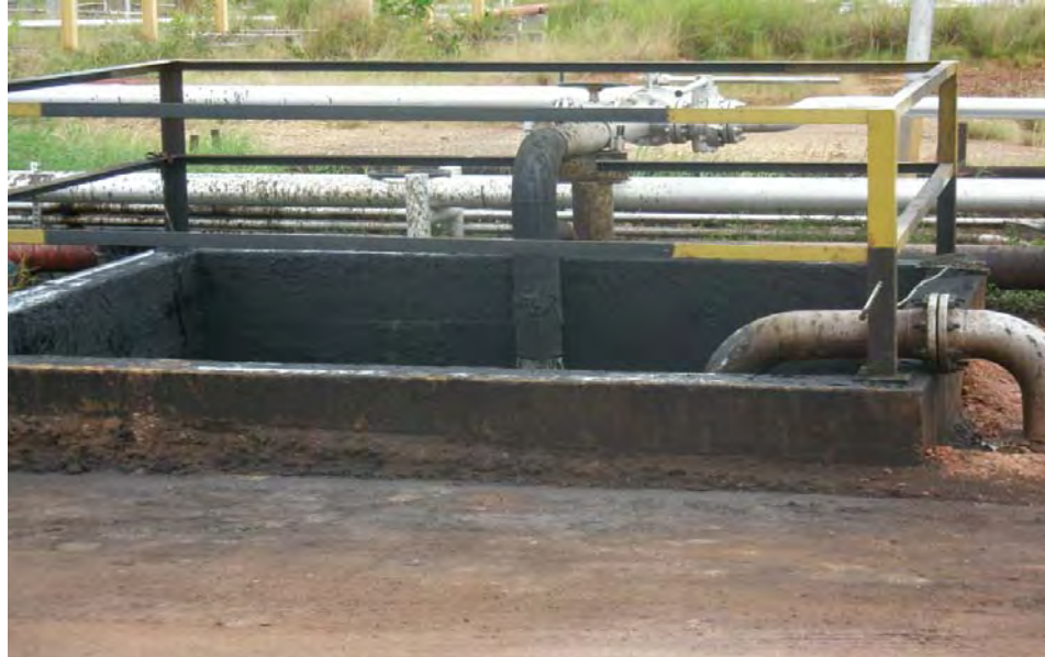
Figura 4.16 Fosa API de 3.50x3.00x2.00 de la Estación de flujo Orocual 1
