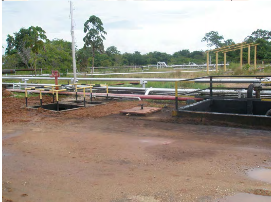
Figura 4.17 Detalles de las Fosas API de la Estación de flujo Orocual 1
