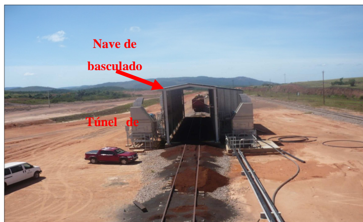
Figura 5.3 Nave de basculado.
