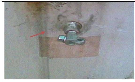
Figura 5.7 Válvula de escape del transformador.
