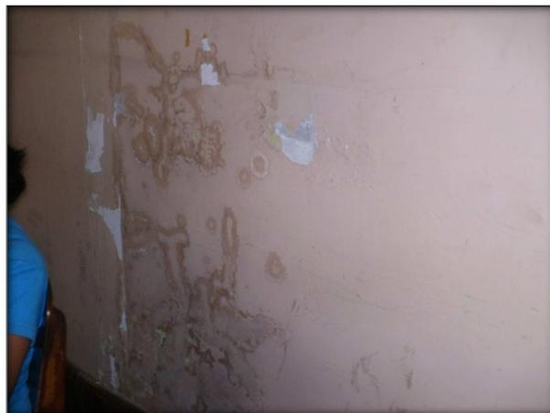
Figura C.2 Filtraciones en las paredes
