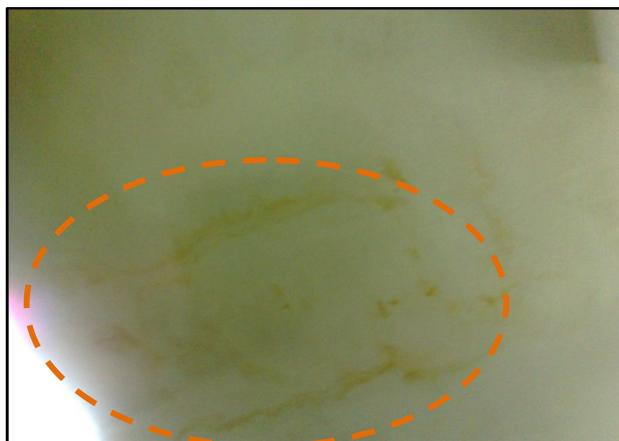
Figura C.9 Humedad en los techos
