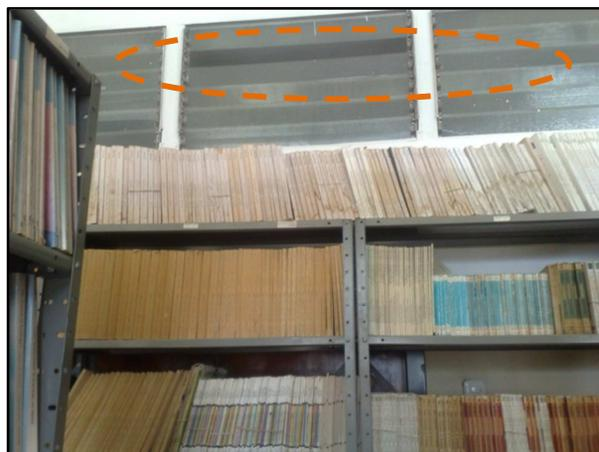
Figura C.11 Ventanas en Mal Estado
