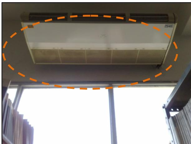
Figura C.15 Aires en Mal Estado
