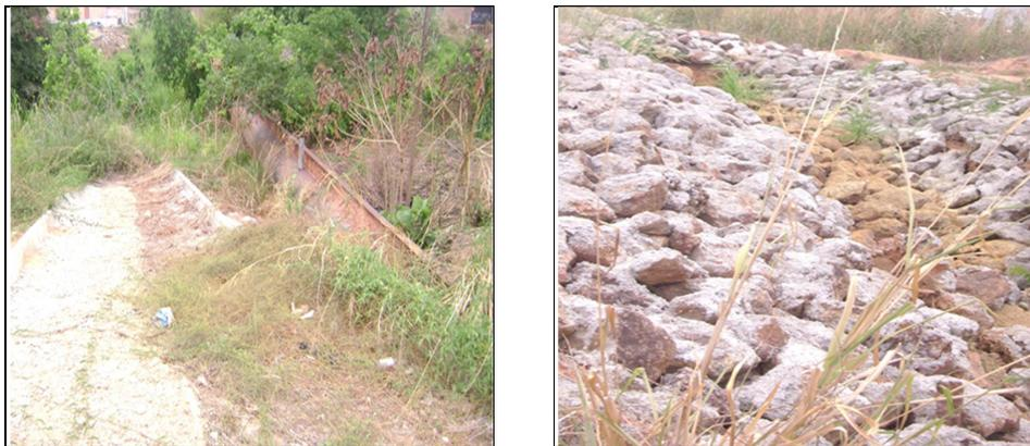
Figura 5.9 Construcción de canal de descarga con pendiente rugosa y surco rellenado con material rocoso y cemento.
