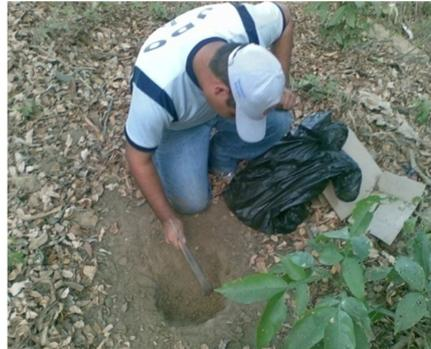
Figura 5.3 excavación de calicata
