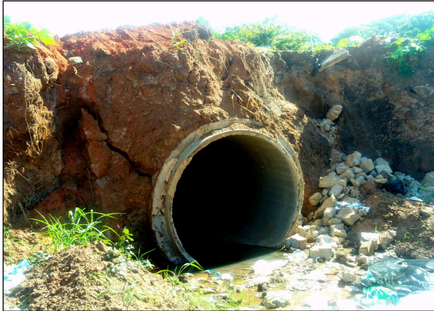
Figura 5.3 Ausencia de cabezal de protección en la alcantarilla en la zona de la descarga.
