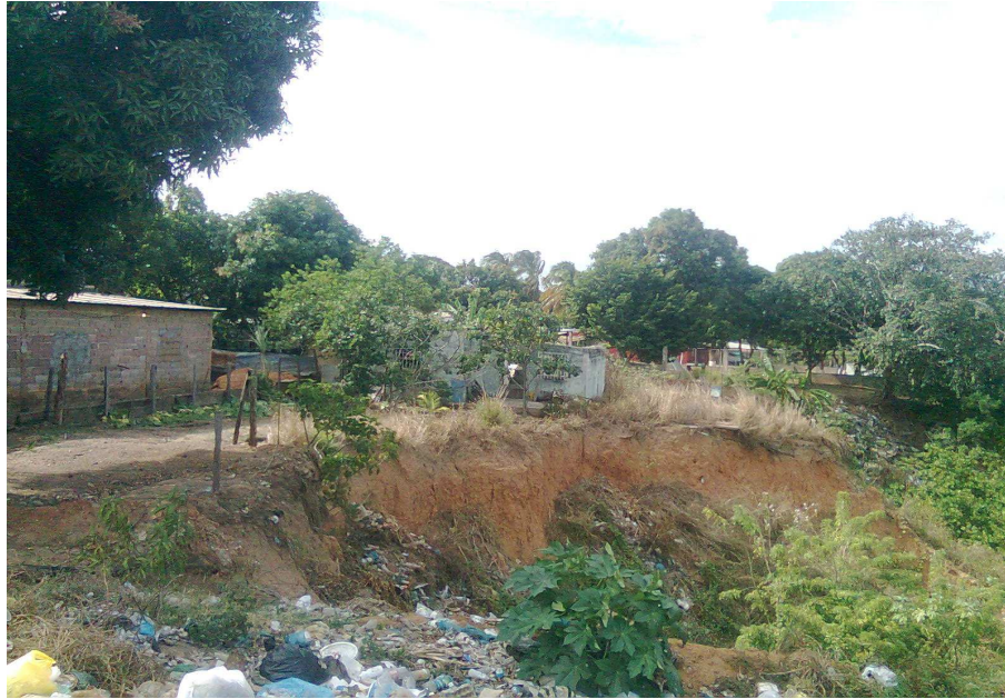
Figura 5.1 Viviendas cercanas a los bordes de la cárcava.
