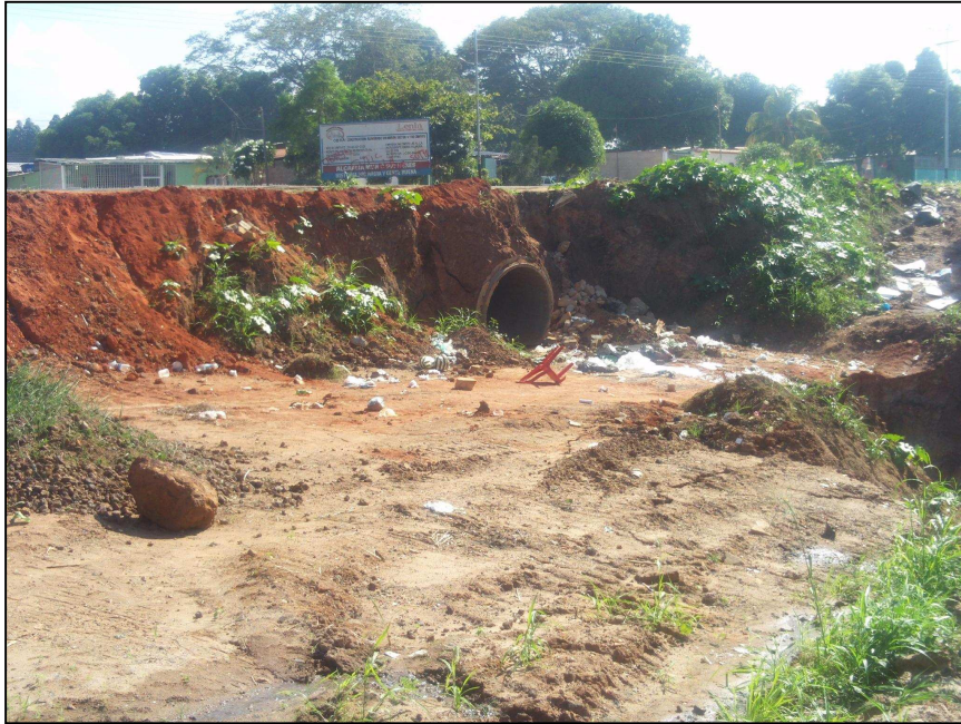
Figura 5.5 Talud de la vialidad sin ningún tipo de protección.
