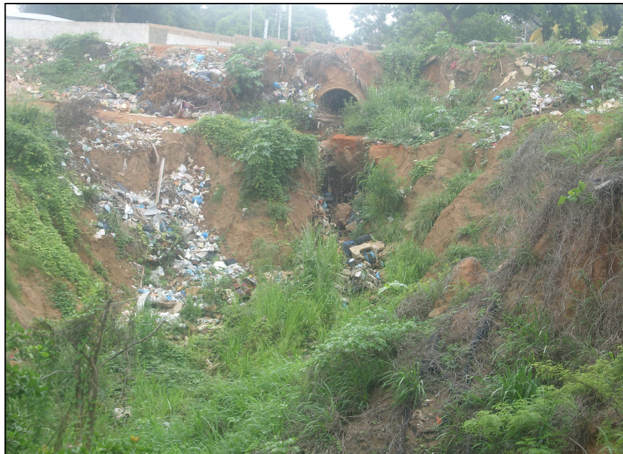
Figura 5.2 Descarga de alcantarilla sin ningún tipo de estructuras de control o disipación de la energía.
