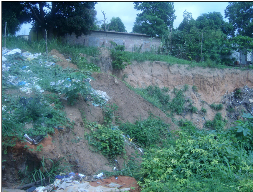
Figura 5.6 Taludes con poca vegetación y sin protección.
