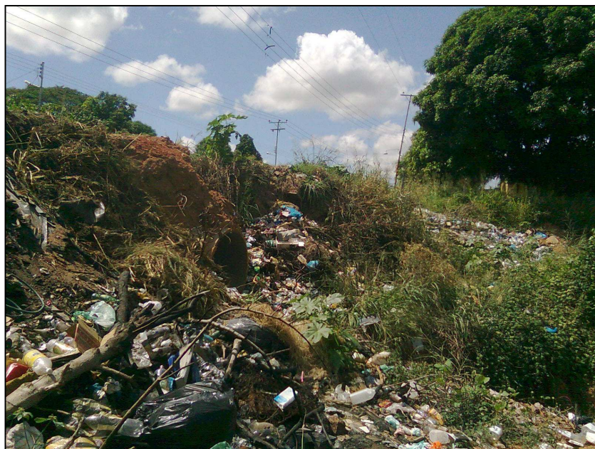
Figura 5.4 Grandes cantidades de basura arrojada por la comunidad en las áreas adyacentes a la alcantarilla.
