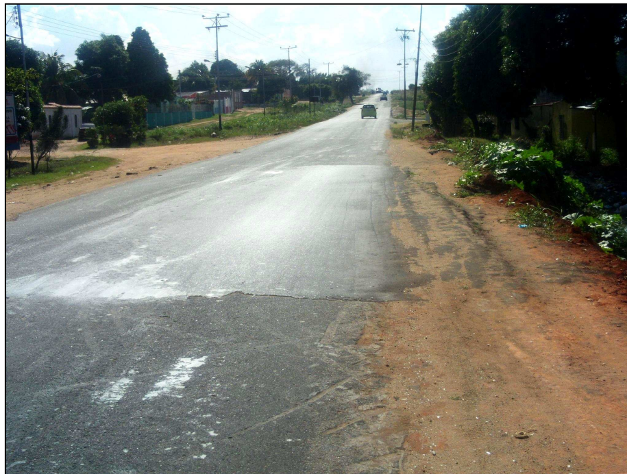
Figura 5.7 Ausencia de brocal en el sentido Av. El Perú – Troncal 19 de la vialidad.
