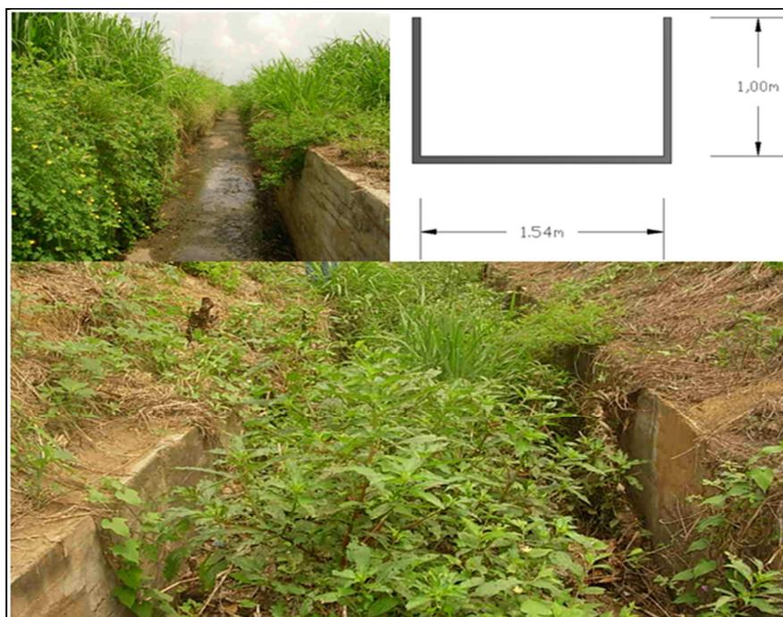
Figura 5.2 Sección B del canal de drenaje.
