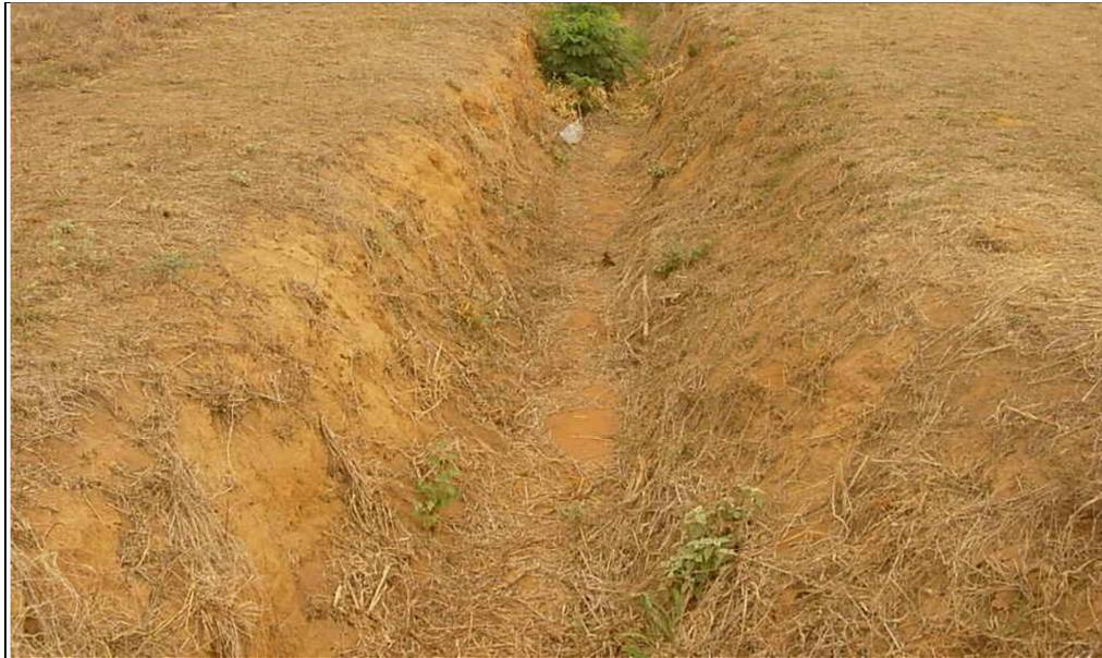
Figura 4.5 Sección trapecial excavado en suelo arenoso. (Julio, 2010).
