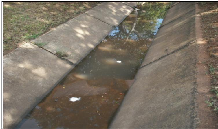
Figura 3.15 Canal revestido de concreto. (Agosto,2010).
