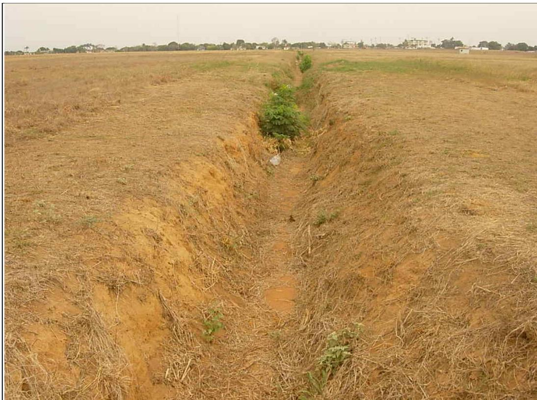
Figura 2.7 Canal del aeropuerto José Tomas de Heres excavado en suelo arenoso (Julio, 2010).
