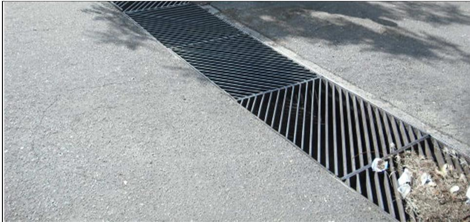
Figura 3.7 Sumidero tipo calzada (parte exterior). (Abril, 2010).
