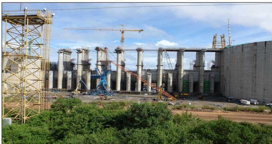
Figura 5.7 Aliviadero, desmontaje de grúas.
