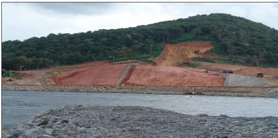
Figura 5.14 Construcción de la ataguía A6.
