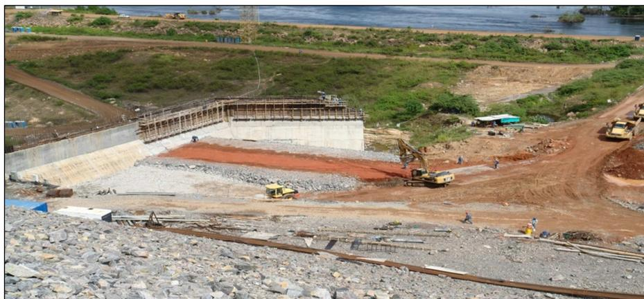
Figura 5.15 Construcción del dique tapón.
