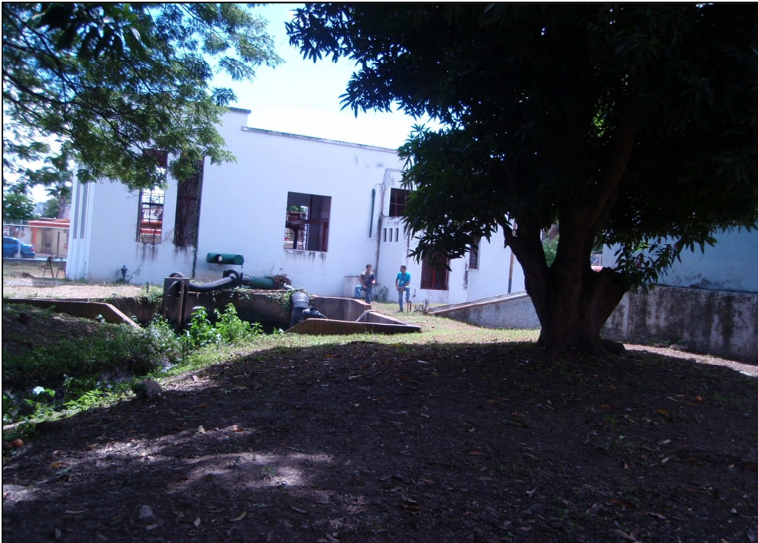
Figura 2.1 Estación de bombeo Bombas Cloacas
