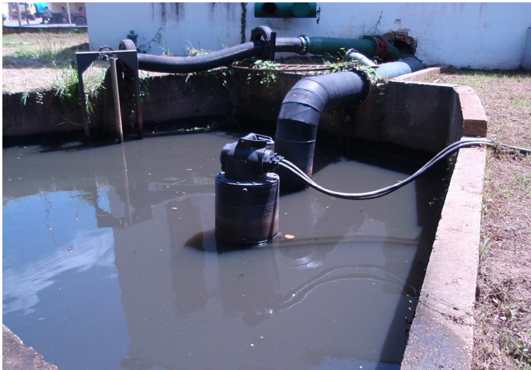
Fig. 5.11 Color típico del líquido cloacal en la estación de bombeo.
