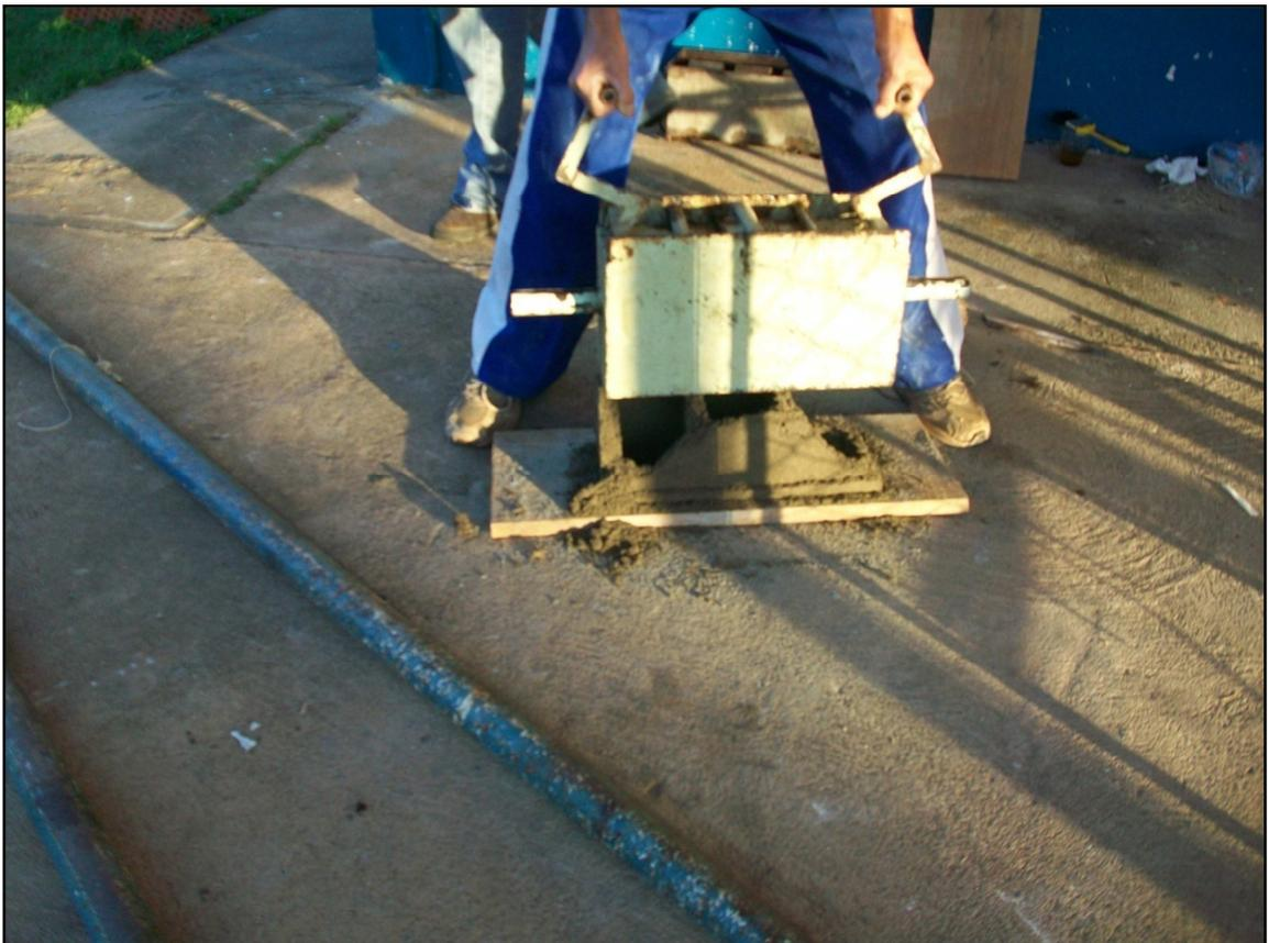
Figura 5.2 Dificultad de moldeado de bloques, con mezclas de aserrín con partículas mayores de 4mm.
