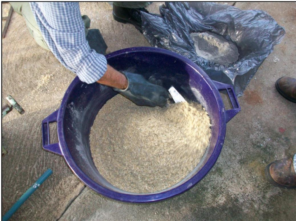
Figura 4.2 Mezclado de aserrín y la cal como mineralizante.
