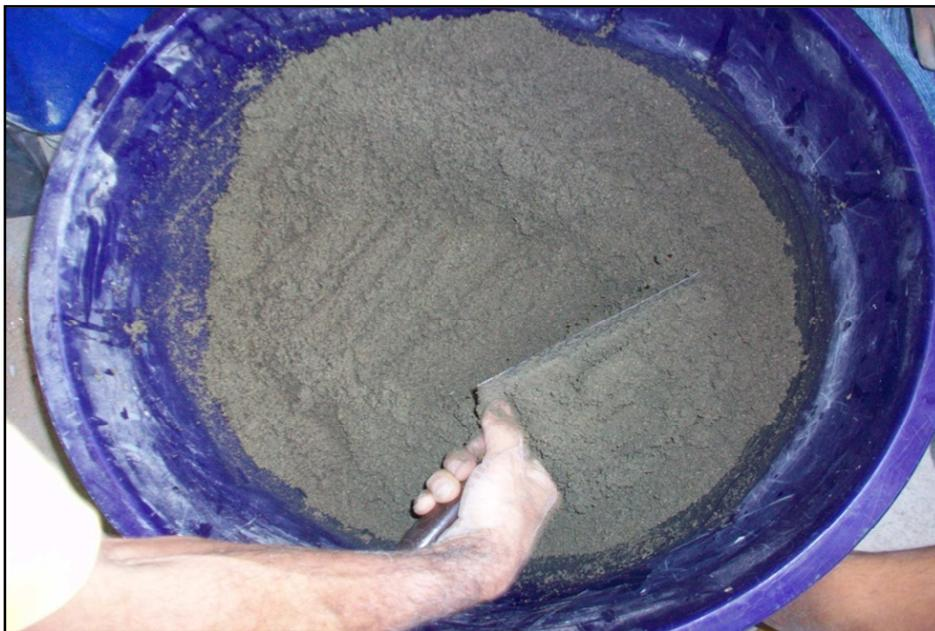
Figura 4.3 Mezclado del aserrín con cemento y agua.
