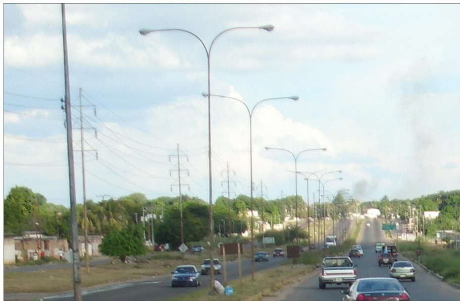
Figura 5.26 Tramo de la Perimetral.
