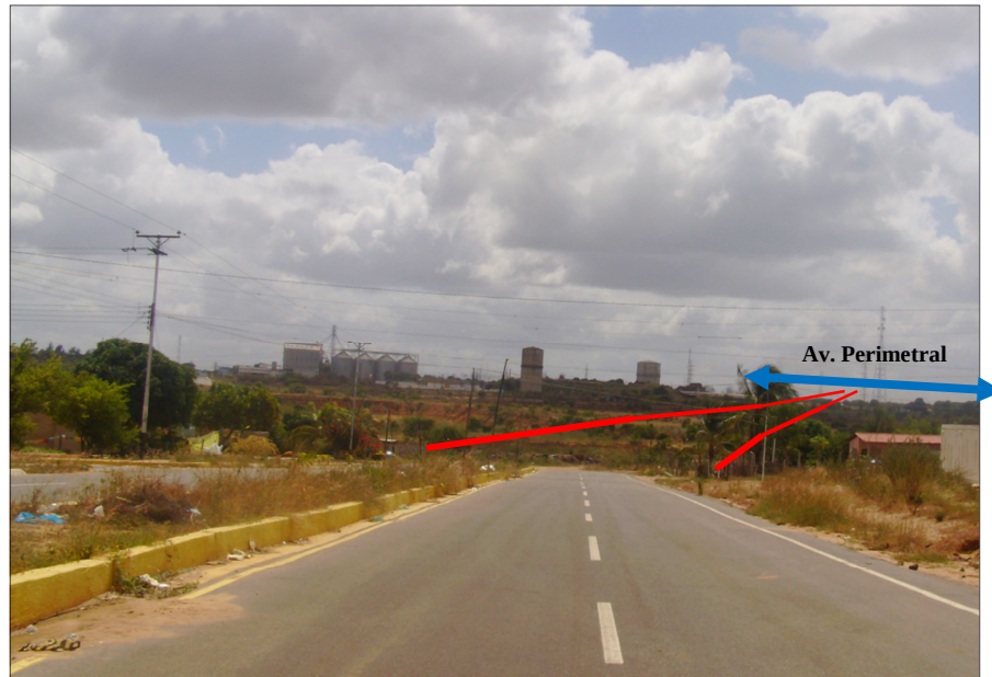
Figura 5.25 Final de la avenida Bolívar, extremo Sur.
