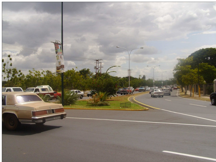
Figura 5.7 Progresiva 0+000 de la avenida La Paragua.
