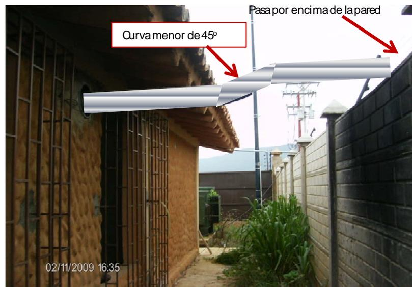
Figura 6.2. Colocación de curva menor de 45o la tubería pasa por encima de la pared
