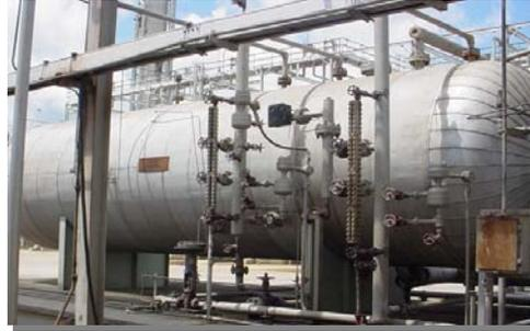
Figura 2.3. Separador trifásico de glicol “flash tank”
