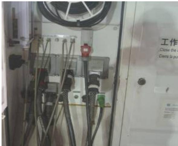
**Figura. 4.4. Conexión de cables de potencia y control en la casa de fuerza del Top Drive.**
