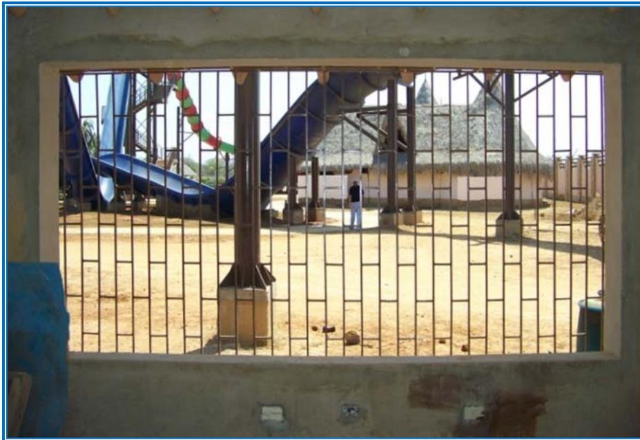
**Figura 4.3.** Ventana delantera de acceso del aire de la Subestación
