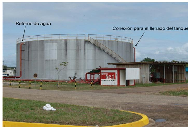
**Figura 3.2: Tanque del sistema contra incendios. [Fuente: Propia]**
