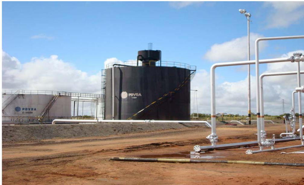
Figura 2.5 Tanque de lavado de GED-14.
