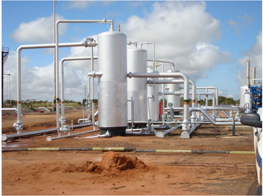
Figura 2.4 Sistema de separadores de GED-14.
