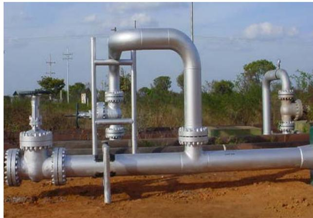
**Figura 4.18. Salto nuevo a tubería de 12" hacia el Este del campo Bare.**
