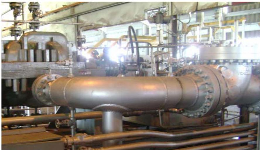
**Figura 4.6. Tubería de Succión hacia la Bomba Centrífuga.**
