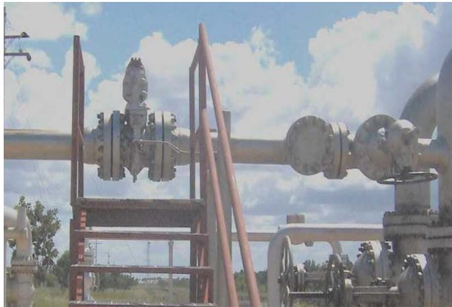
**Figura 4.17. Orificio de restricción en salto hacia Bared – 3, 4, 5, 6, 7 y 9.**
