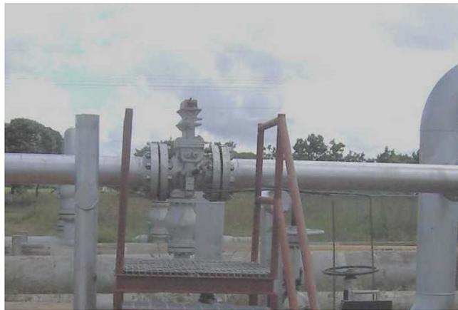
**Figura 4.16. Orificio de Restricción en Salto hacia Arecuna.**
