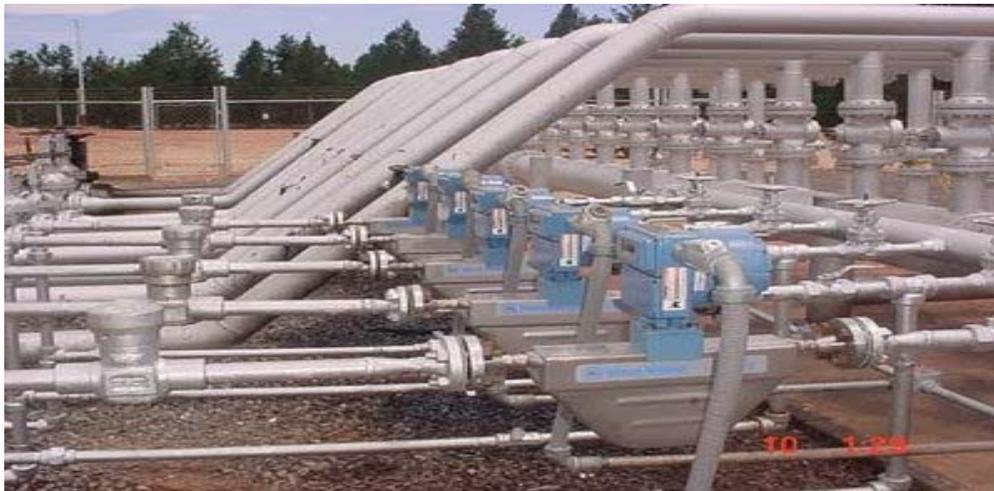
**Figura 2.5.** Los Coriolis instalados en el múltiple de inyección de diluyente para realizar la medición correspondiente a la dosificación de cada pozo.
