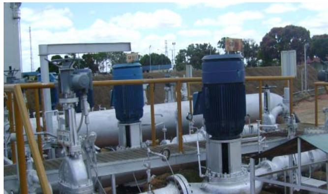
**Figura 4.3. Cuatro Bombas tipo Booster.**
