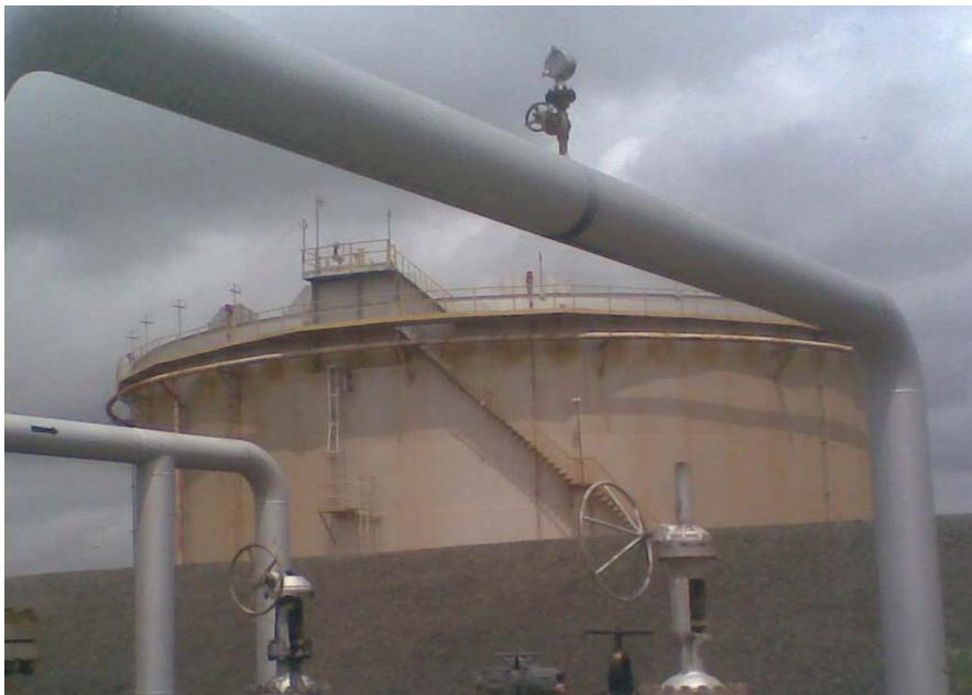
**Figura 4.8. Tanque de Almacenamiento de Diluyente en el C.O.B de Cubierta Interna Flotante.**
