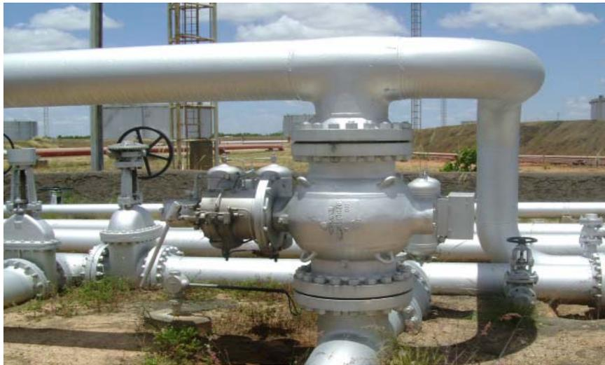
**Figura 4.5. Cabezal de Succión de las Bombas.**
