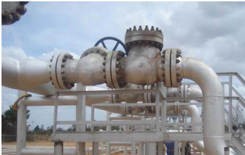
**Figura 4.23. Descarga del Sistema de Rebombeo.**
