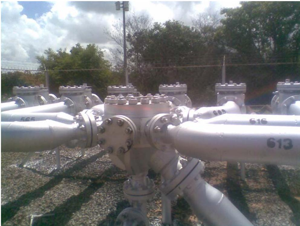
**Figura 2.2 Sistema Manual de Inyección de Diluyente de 7 Puertos.**
