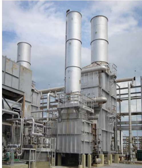
Fig. 3.3. Recuperador de calor D1.71001 (Derecha), Chimenea (Izquierda). Fuente: Imagen Propia
