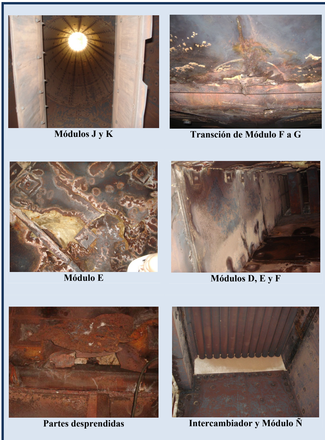
Fig. 4.8. Condiciones internas del SRC asociado al Turbocompresor D4.81007.
