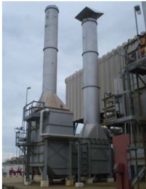
Fig. 3.4. Recuperador de calor D1.81005 (Izquierda) y Chimenea (Derecha). Fuente: Imagen Propia
