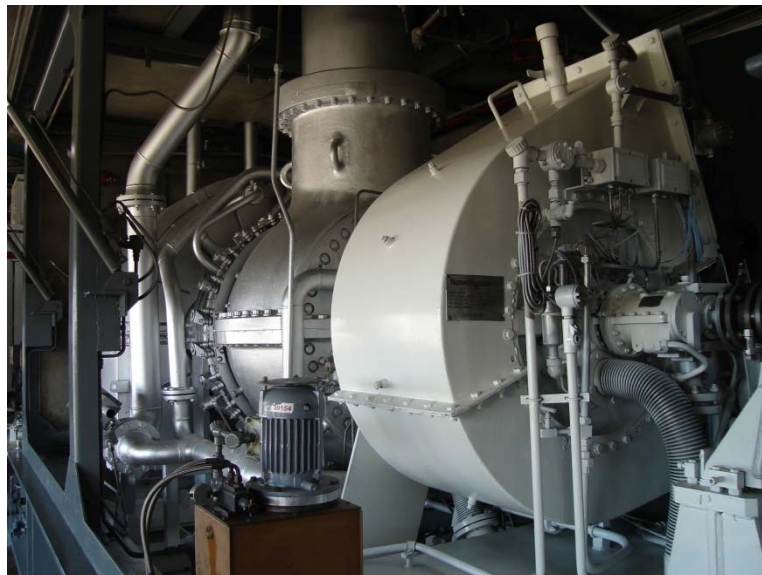
Figura 4.1. Turbina a gas PGT5 perteneciente al turbocompresor D4-81001.
