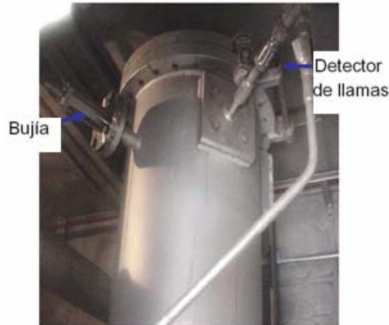
Figura 2.8. Cámara de Combustión.
