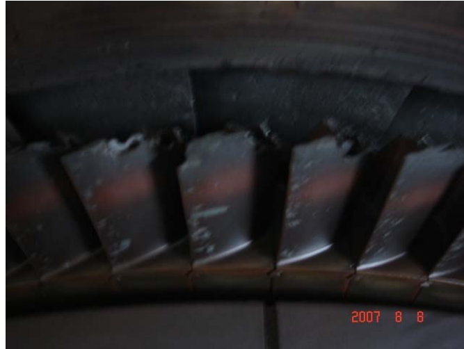
Figura 4.2. Álabes rotos pertenecientes a la turbina a gas PGT5.
