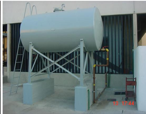
Fig. 2.2.a Tanque de combustible diario Fig. 2.3.b Tanque de combustible principal
