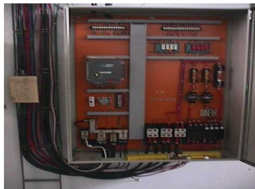
Fig. 2.5. Interruptor automático de transferencia
