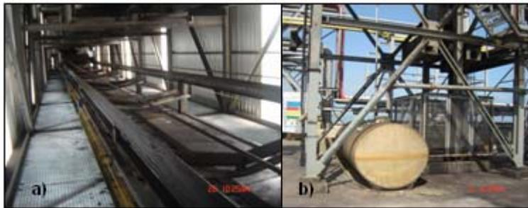
**Figura N° 3.18.** a) El sistema de canales colector de residuos y b) Sumidero (tanque) de residuos líquidos de todo el sistema. [Fuente Propia].
