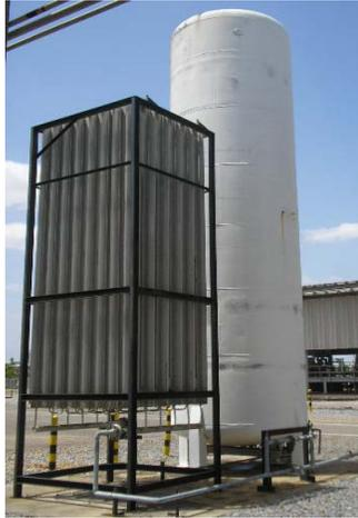
**Figura 2.19.** Sistema de Suministro de Nitrógeno, Planta de Extracción San Joaquín.
