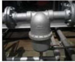
**Figura 2.11.** Recipiente Deshidratador D8-33701, Planta de Extracción San Joaquín.
