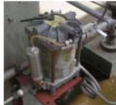
**Figura 2.12.** Trampa de Líquidos del Sistema de Aire, Planta de Extracción San Joaquín.
