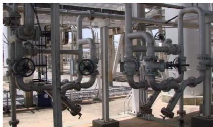
**Figura 2.17.** Filtros de Aire D11-33701/02/03/04, Planta de Extracción San Joaquín.
