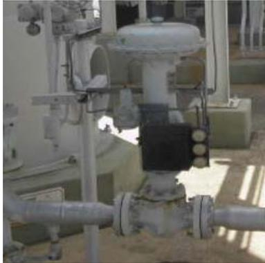
**Figura 2.14.** Válvula de Control PIC-33709
