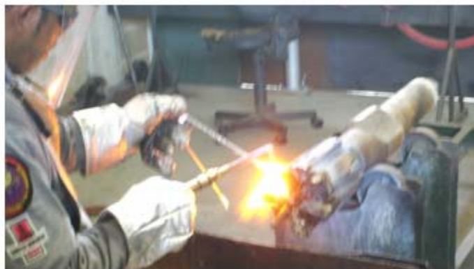
Figura 4.6. Colocación y soldadura del material abrasivo
