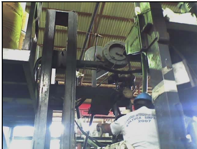
Figura 3.4 Se puede observar la unión entre la plataforma y el cabezal de soldadura
