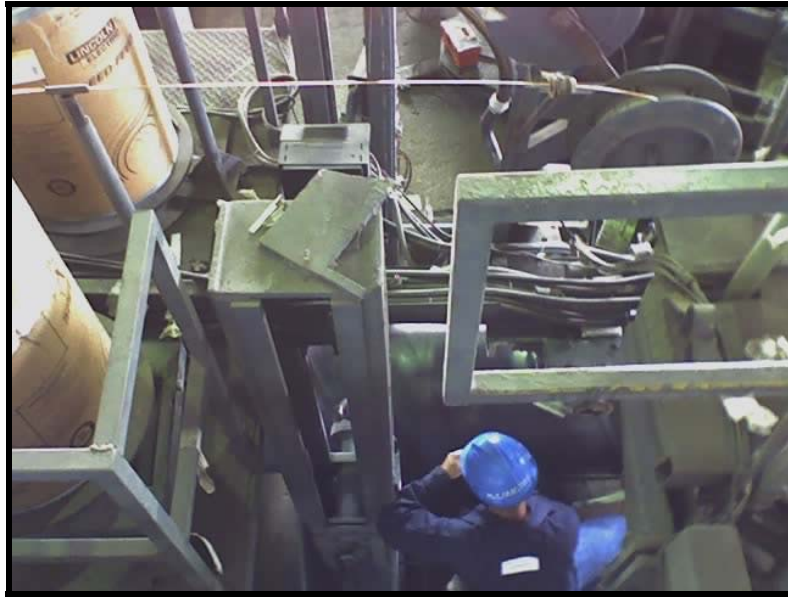
Figura 3.5 Se puede observar los rollos de electrodos, cabezales provenientes de la maquinas de soldadura y la unión entre la plataforma y el cabezal de soldadura
