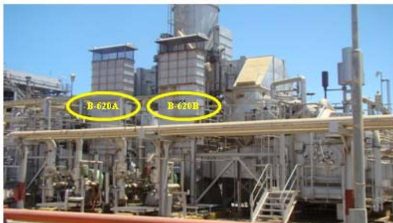
Figura 4.9. Calderas de recuperación de calor B-620A y B-620B
