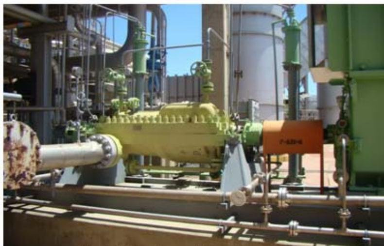
Figura 4.4. Bomba centrífuga multietapa P-621B
