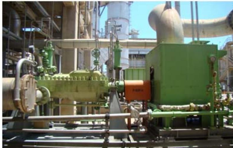
Figura 4.3. Bomba centrífuga multietapa P-621A
