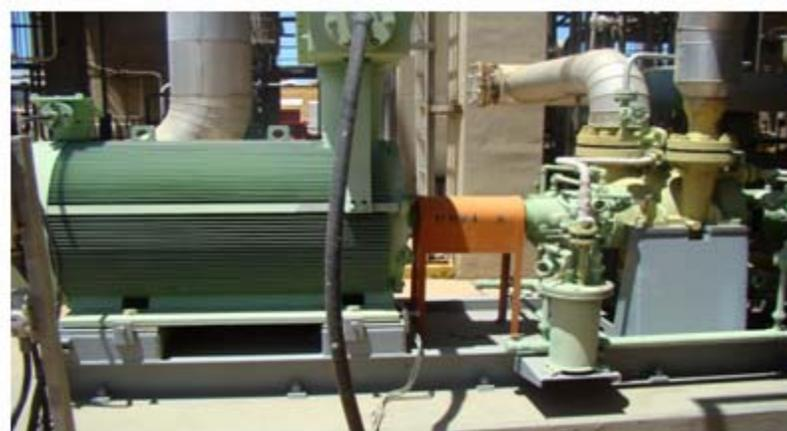
Figura 4.8. Bomba centrifuga multietapas P-624B
