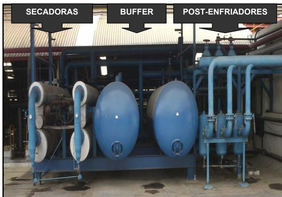
Figura 3.6. Vista de las secadoras, buffer y post-enfriadores.
