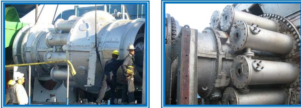
**Figura 4.5. Cámaras de Combustión de las unidades turbogeneradoras modelo FRAME [Propia]**
