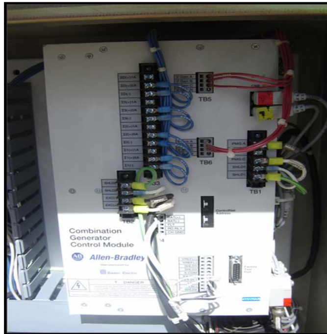
Figura 3.3. Conexiones Actuales del Modulo de Combinación
