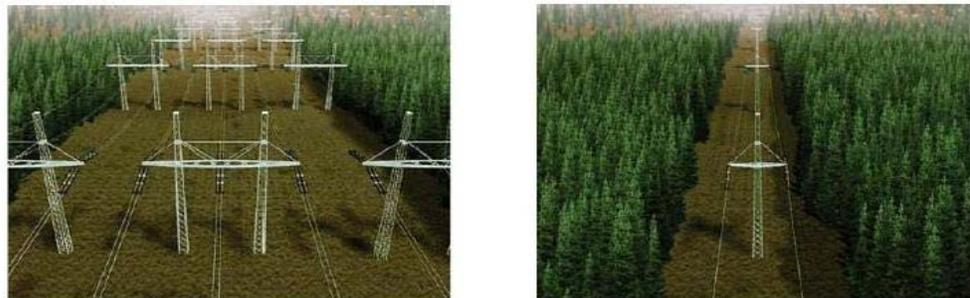
**Figura 4.47 Franja de servidumbre para el caso 500 KV HVAC y  $\pm 500$  HVDC para transportar 3000 Mw [7].**
