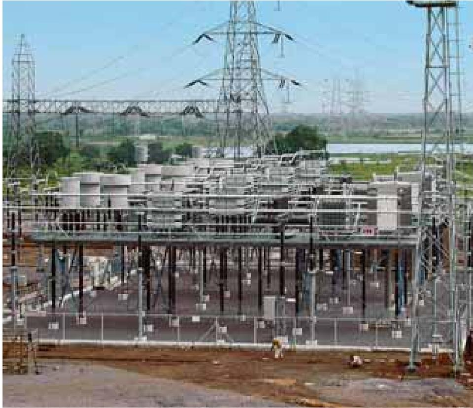
Equipo TCSC utilizado para amortiguar la oscilación de potencia
