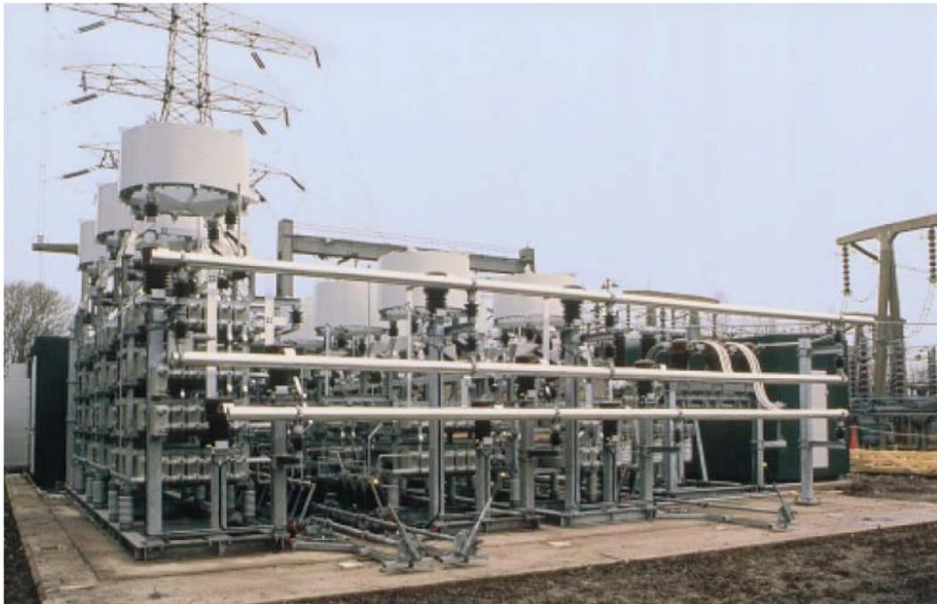
Compensador estático de potencia reactiva, desplazable, en la subestación de NGC en Penn (Gran Bretaña).
