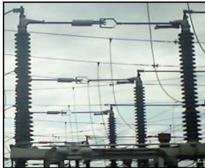
Figura 2.4 Seccionador de Potencia
