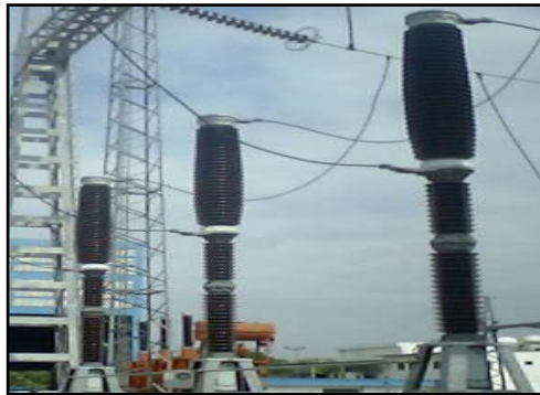
Figura 2.5 Disyuntores de Potencia
