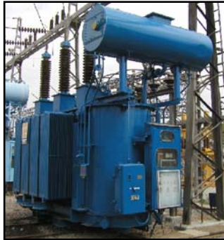
Figura 2.1 Transformador de Potencia
