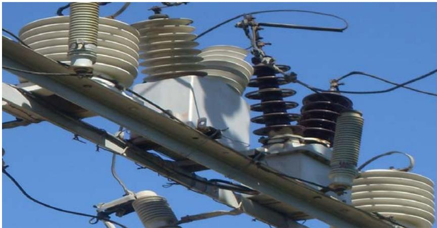
Figura 3.2. Transformadores de medida externos para contadores de KWH y KVARH.
