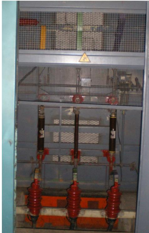
Figura 3.6. Seccionador de corte en carga con dispositivo de desconexión por fusión de fusible y electroimán.
