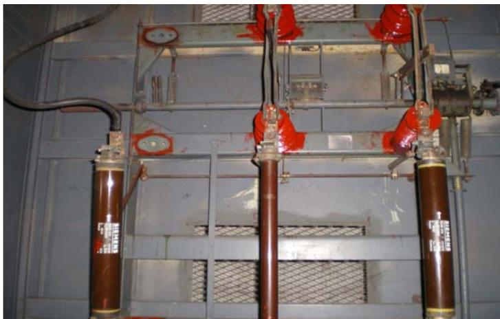
Figura 3.12. Cable sustituyendo corta fusible.
