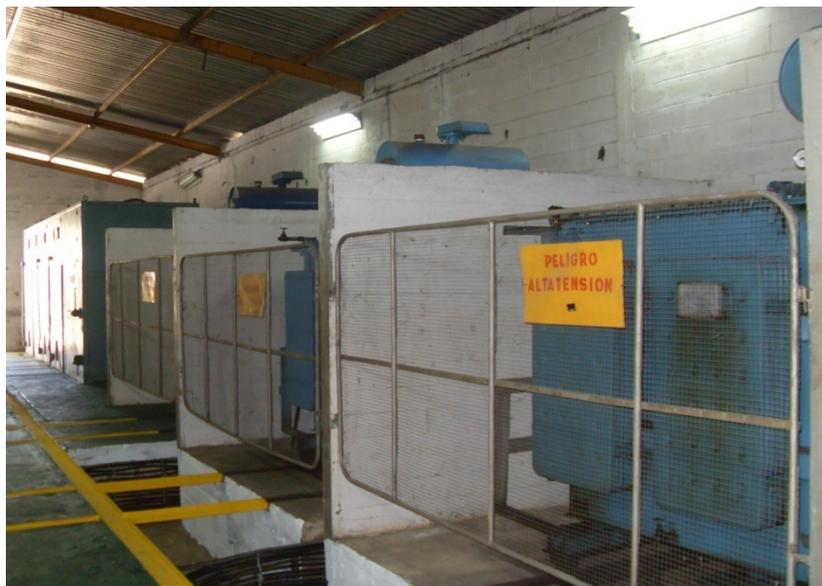
Figura 3.9. Transformadores de potencia.
