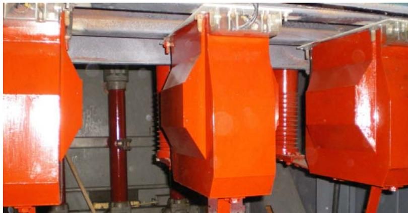
Figura 3.3. Transformadores de medida internos, para instrumentos de protección.
