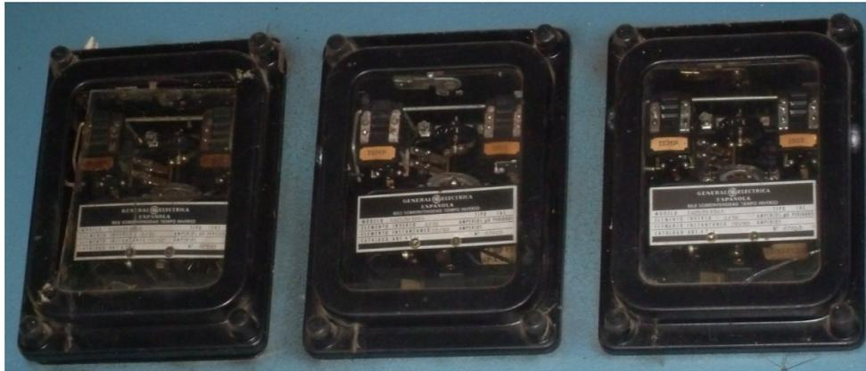
Figura 3.7. Relés electromagnéticos de sobre corriente (50/51).
