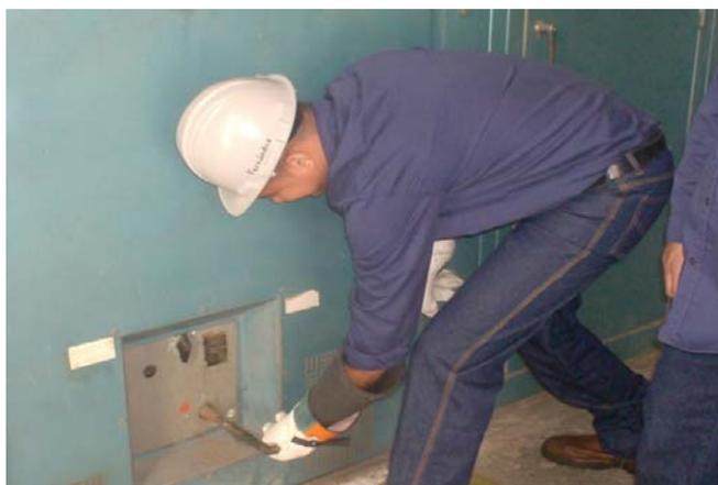
Figura 3.11. Maniobra para conectar el interruptor automático de pequeño volumen de aceite.
