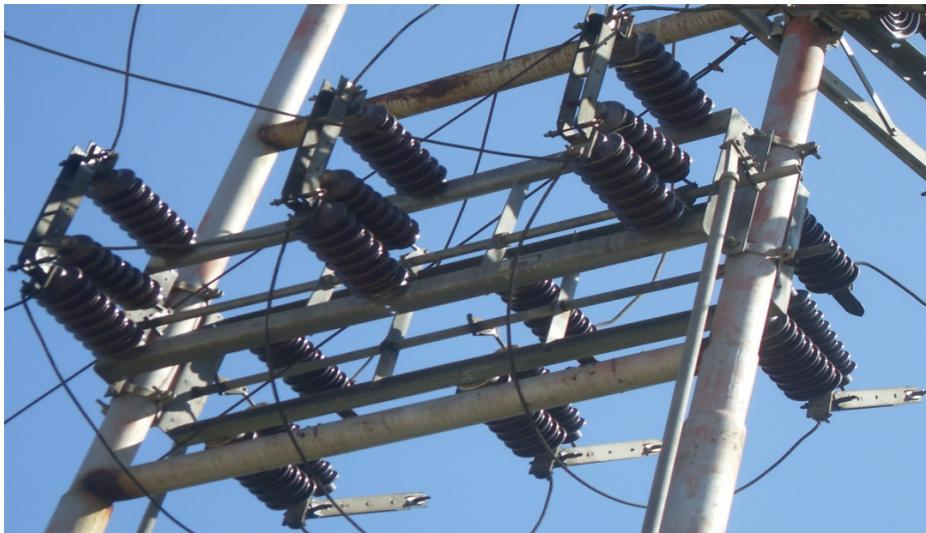
Figura 3.4. Seccionadores tripolares para transferencia de líneas.
