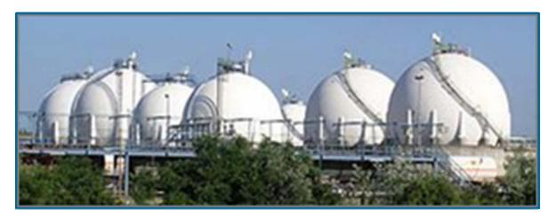
Figura 2.5 Tanques presurizados esféricos
