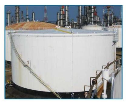
Figura 2.1 Tanque de techo cónico
