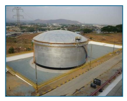
Figura 2.2 Tanque de techo flotante cerrado
