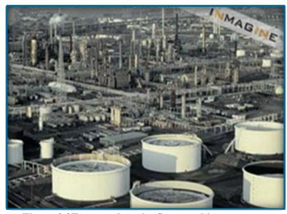
Figura 2.3Tanques de techo flotante abierto
