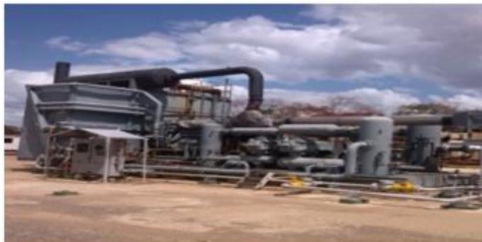
**Figura 2.1.Unidad Moto-Compresora o Moto-Compresor de la PCMR**
