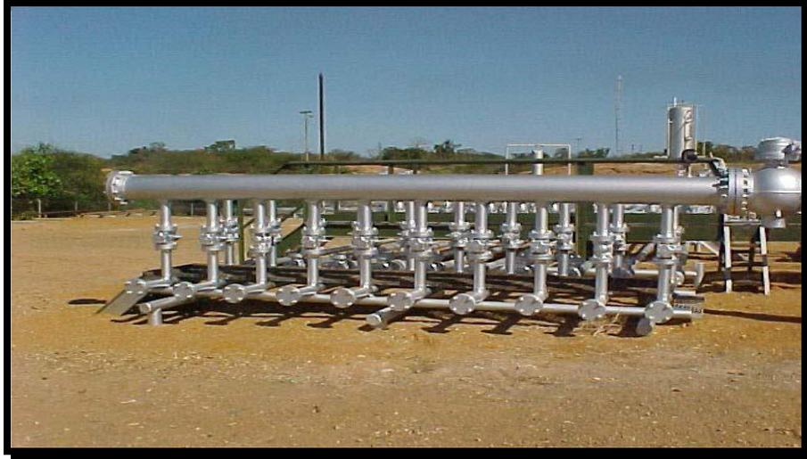
**Figura 4.2 Múltiple de producción de 10 puestos instalado en la estación de flujo SFSR de AMAE.**
