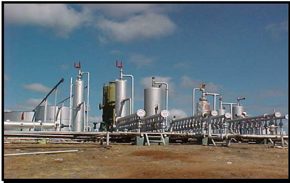
**Figura 4.1 Estación de flujo utilizada para la separación gas-liquido en el Área Mayor Anaco Este (AMAE)**
