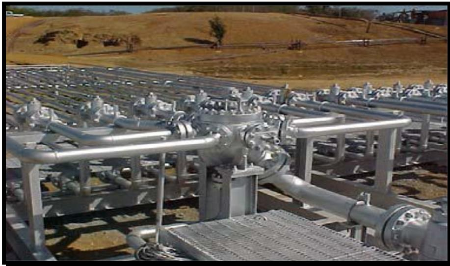
**Figura 4.3 Válvulas multipuertos instaladas en estación SFSR de AMAE**
