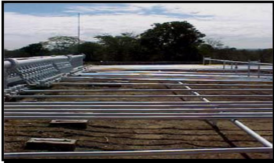
**Figura 4.4 Líneas para la conexión de los pozos con el múltiple de producción**
