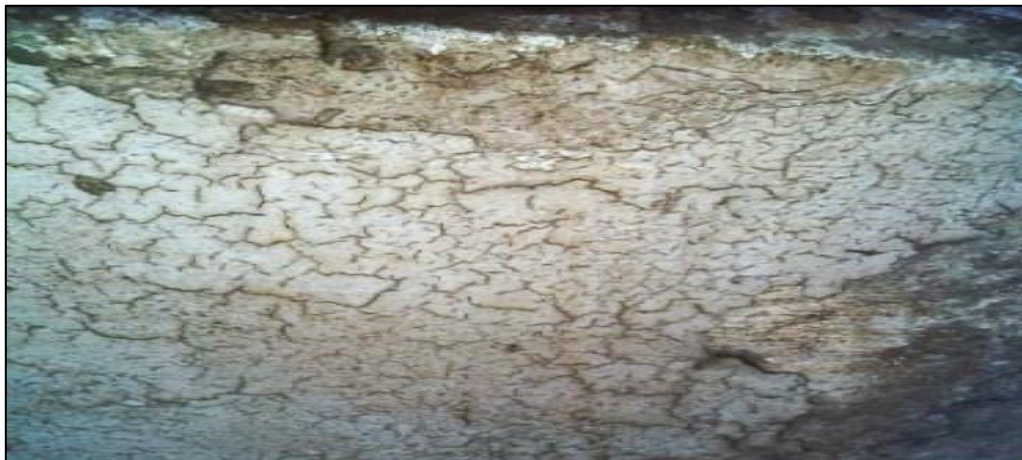
Figura 5.6 Desprendimiento de pintura en pilar de humedad
