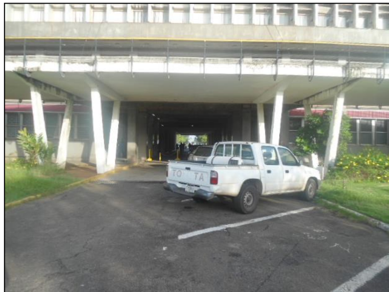
Figura5.1 Rampa del edificio administrativo I
