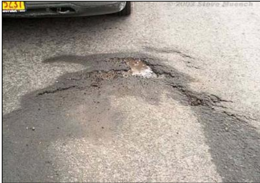
Figura 3.25 Grieta por desplazamiento. (Corredor G., 2008).
