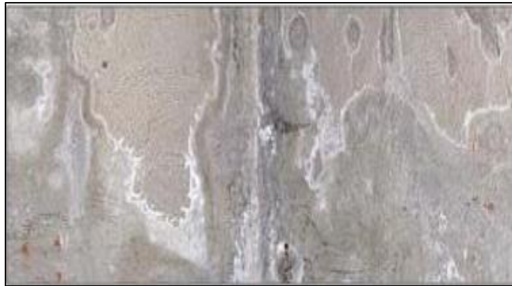
Figura 3.18 Eflorescencias. (construmatica.com)
