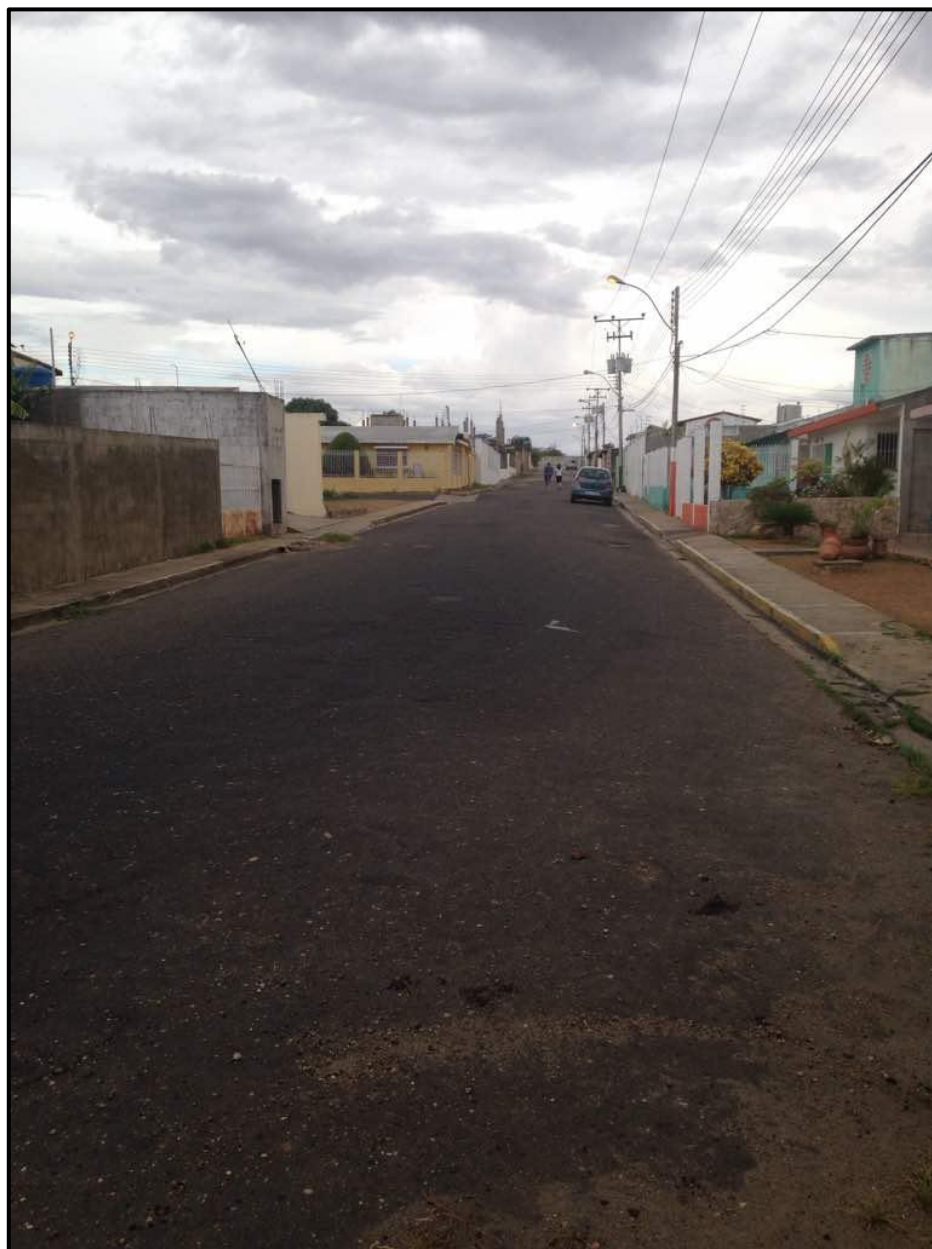
Figura 9.20 calle principal de la urbanización Santa Claro, lado Oeste, en la cual se colocaría parte del colector secundario. Tramos G1-E1-D1-C1-A. Sentido SE.
