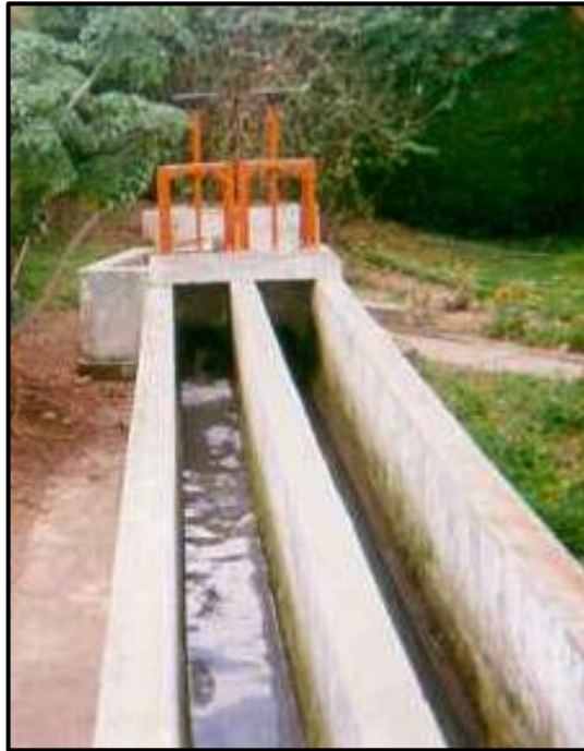
Figura 3.24 Desarenador
