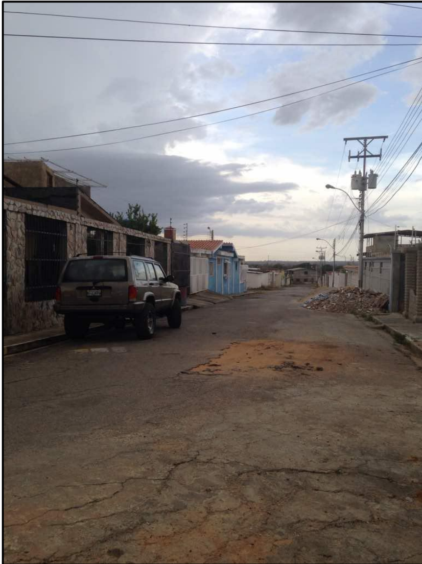
Figura 9.19 calle principal de la urbanización Canta Claro, lado Este, en la cual se colocaría el colector principal. Tramos B-C-D-E-F. Sentido NO.
