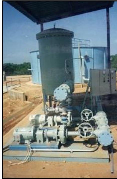
Figura 3.26 Sistema de flotación de aire disuelto.
