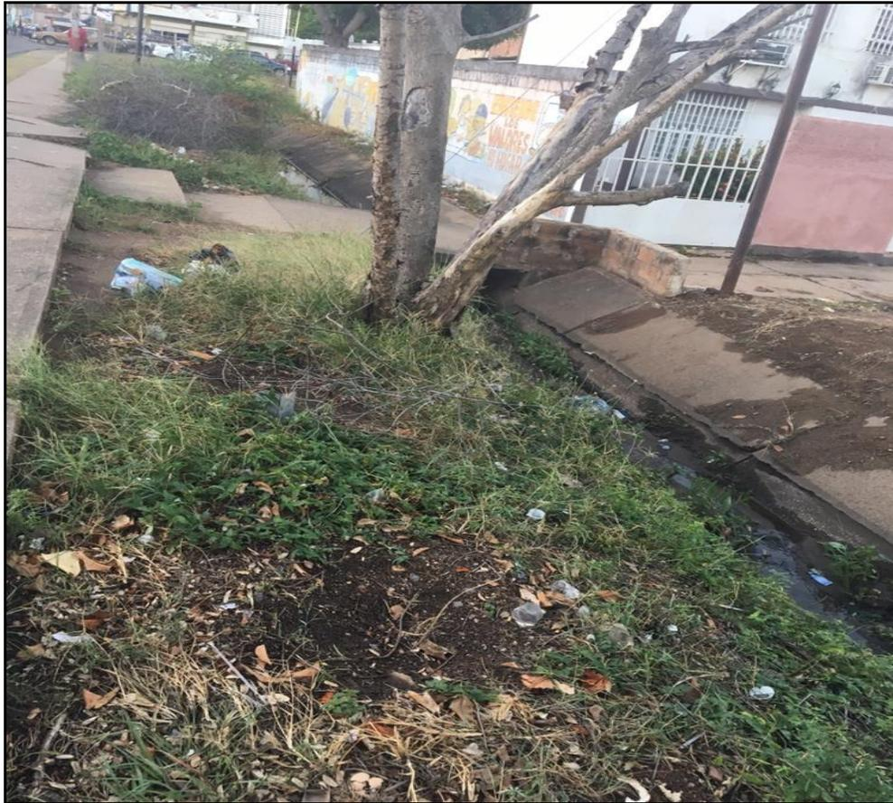
Figura 5.1 Cobertura vegetal y acumulación de aguas servidas en el canal de drenaje.
