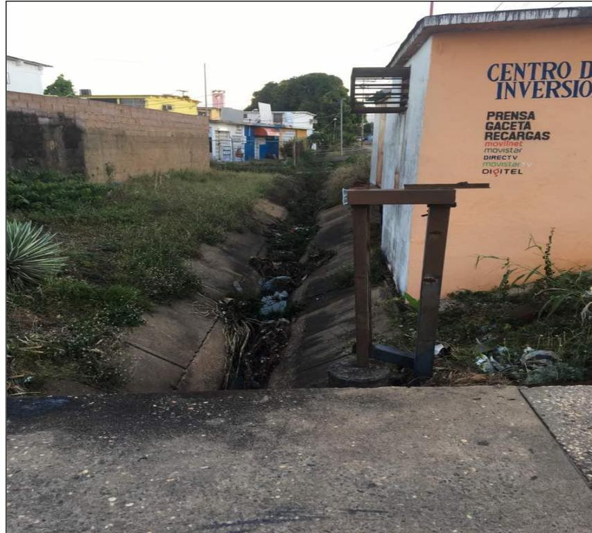
Figura 5.2 Presencia de aguas negras y malezas dentro del canal.
