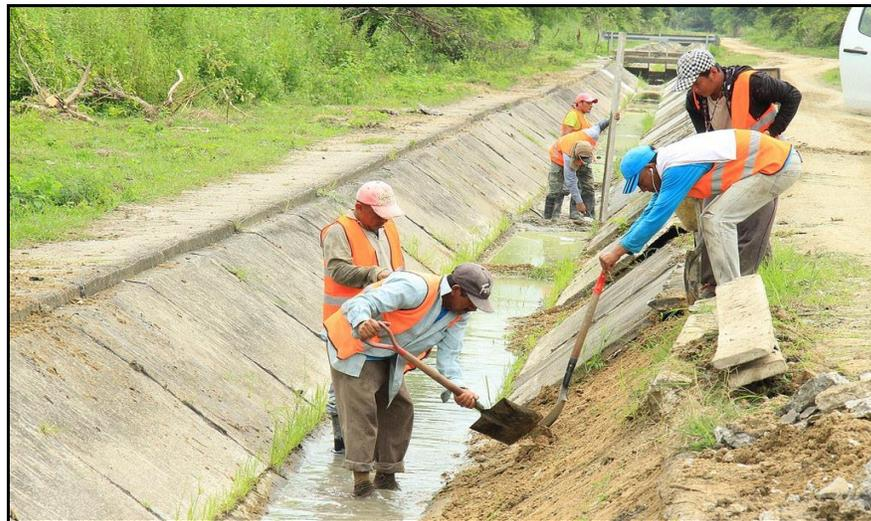
Figura 5.8 Limpieza del canal de drenaje.
