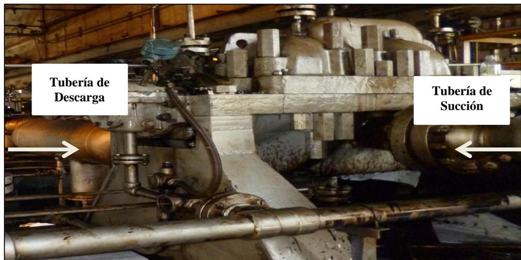
Figura 5.1 Bomba de Sala de Bombas Principal de Diluyente, PT-10 (PDVSA 2016)
