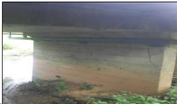
Figura 5.5 Soporte tipo losa y pila del puente Las Flores Norte (Córdova, 2019).
