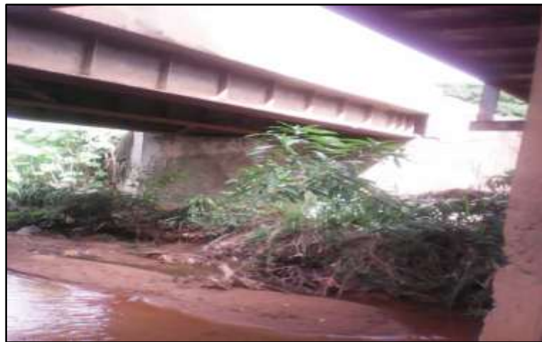
Figura 5.4 Vigas de soporte del puente Las Flores Sur (Córdova, 2019).
