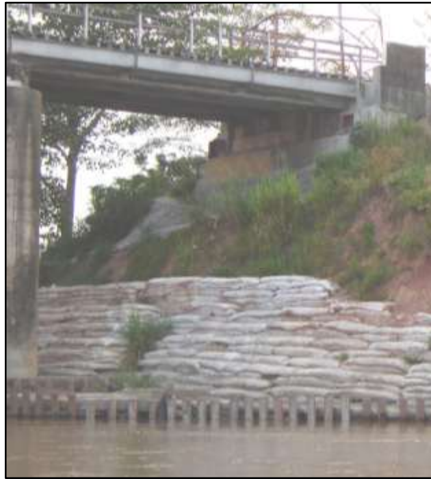
Figura 3.15 Obras de protección contra la erosión, muro en bolsacretos, puente en Puerto Berrío, margen derecha, asentamiento de Puerto Olaya (Otálvaro, M., 2007).
