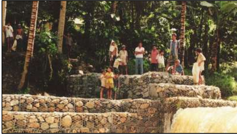
Figura 3.14 Protección de márgenes por medio de gaviones. (Alfredobi, 1999).
