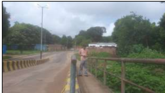
Figura 5.2 Estructura del puente Las Flores vista desde la vialidad en la cual transitan los vehículos (Córdova, 2019).
