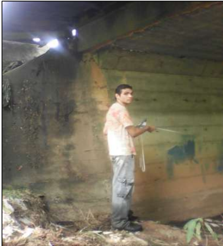
Figura 5.3 Estribos del puente Las Flores (Cordova, 2019).
