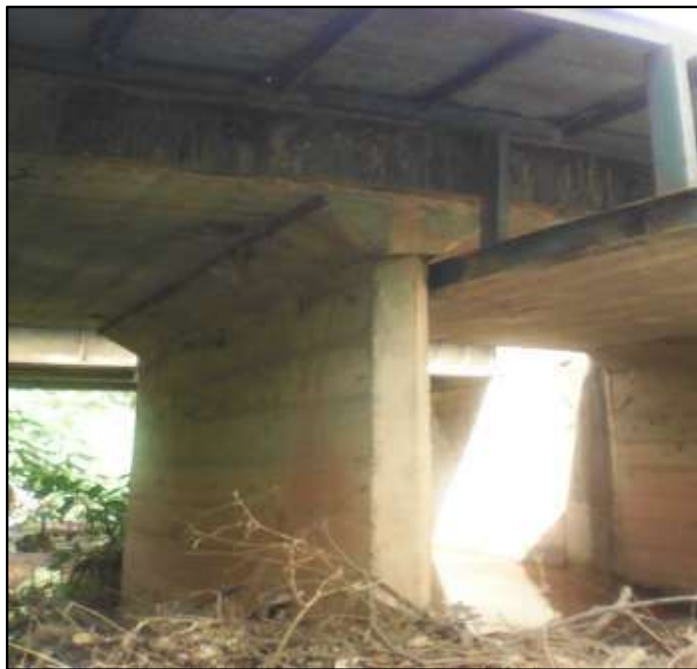
Figura 5.10 Pila y estribo oriental del puente sin evidencia de socavación (Córdova, 2019)
