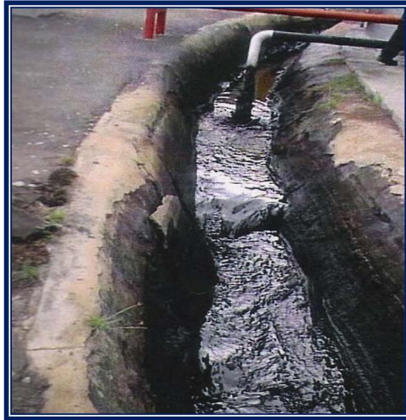
**Fig. 9. Proceso de drenaje "agua con hidrocarburo"**
