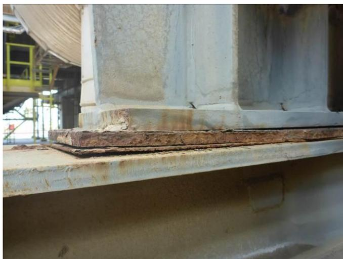
**Figura 4.14. Corrosión leve en la estructura metálica de soporte del E-4101A. Fuente: Supermetanol, C.A**
