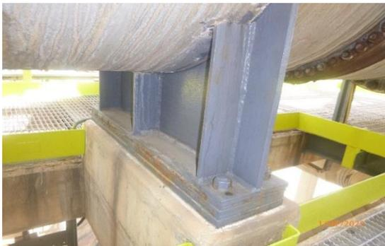
**Figura 4.51. Soporte en sitio del rehervidor E-4103. Fuente: Propia.**
