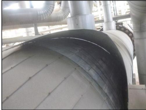
**Figura 4.32. Desprendimiento de chaqueta metálica. Fuente: Supermetanol, C.A**
