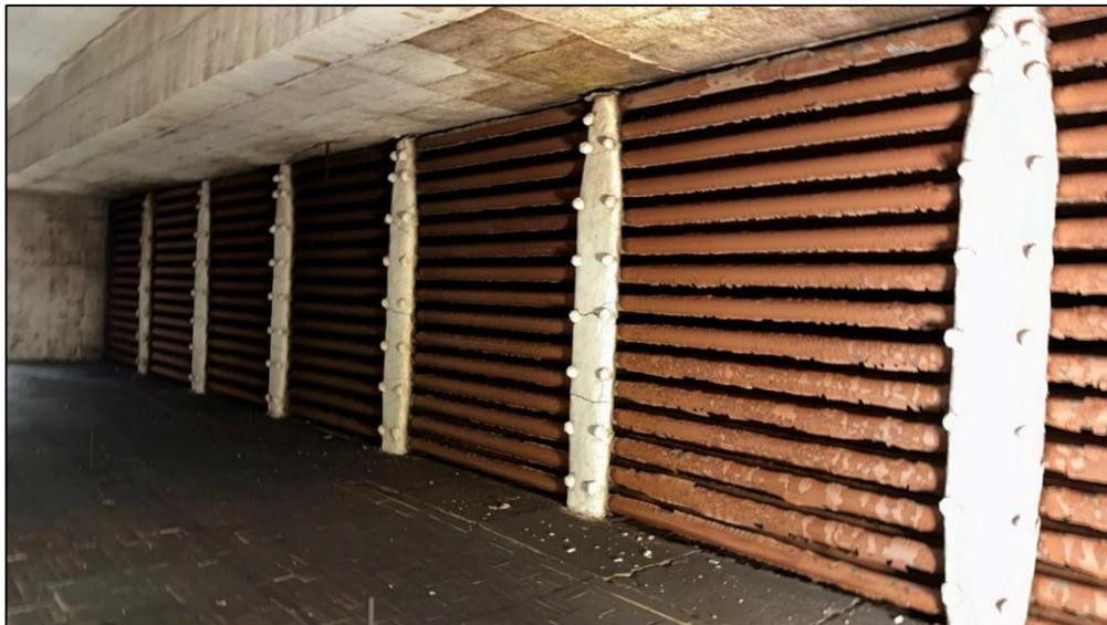
**Figura 4.35. Corrosión presente en los tubos del intercambiador E-4110.**
