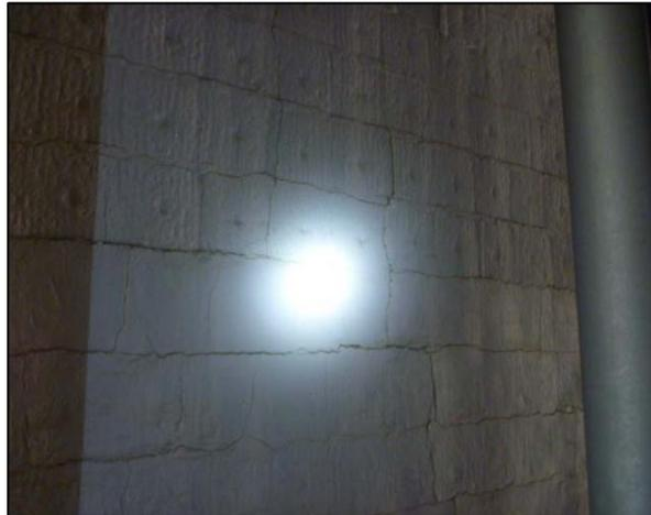
**Figura 4.7. Agrietamiento del material refractario de pared oeste.**
