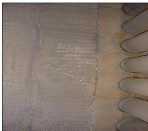
**Figura 4.19. Agrietamiento presente en placa tubular final del E-4113.**
