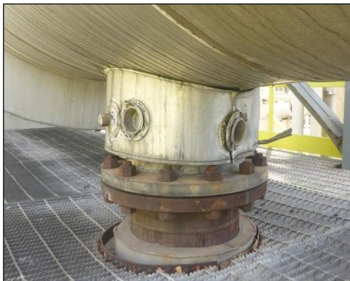
**Figura 4.23. Abertura y abolladuras de la chaqueta metalica ubicada en cabezal inferior del E-4102. Fuente: Supermetanol, C.A**
