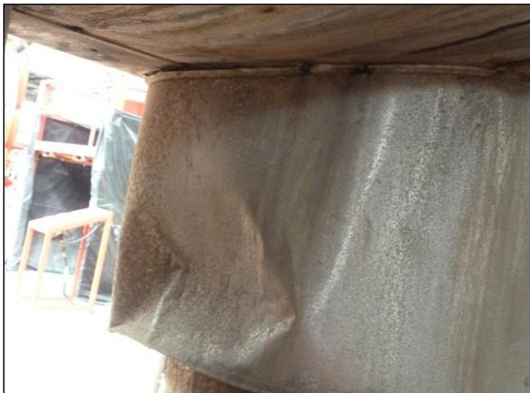
**Figura 4.30. Deformación y desprendimiento de chaqueta metálica de protección mecánica en zona inferior del E-4120B. Fuente: Supermetanol, C.A**
