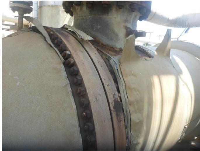
**Figura 4.49. Deterioro de la chaqueta metálica y falta de reemplazo.**
