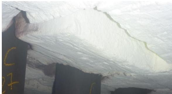
**Figura 4.45. Desprendimiento de modulo refractario en techo de zona radiante. Fuente: Propia.**
