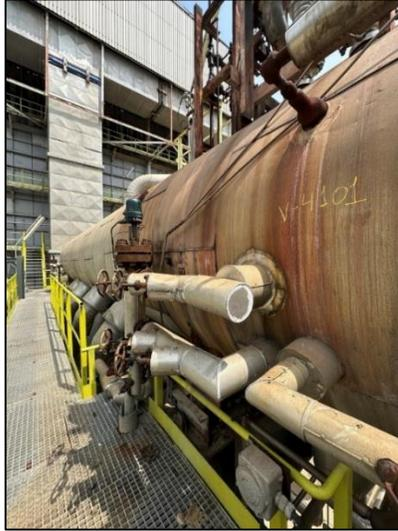
**Figura 4.37. Oxidación y deterioro en el sistema de protección mecánica del tambor V-4101. Fuente: Supermetanol, C.A**
