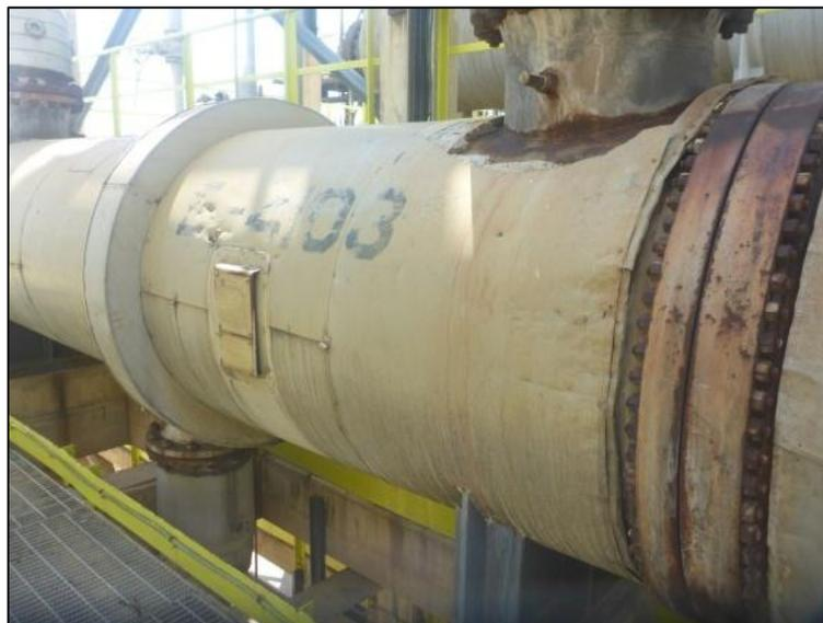
**Figura 4.25. Deterioro y aberturas del sistema de protección en cabezal superior del E-4103. Fuente: Supermetanol, C.A**
