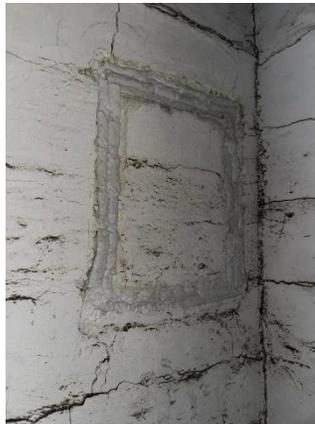
**Figura 4.46. Agrietamiento de material refractario en pared de zona radiante. Fuente: Propia.**
