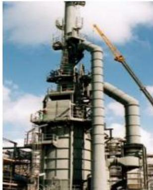
**Figura 2.4. Horno tipo cilindro vertical. Fuente: FOSTER WHEELER (2013)**
