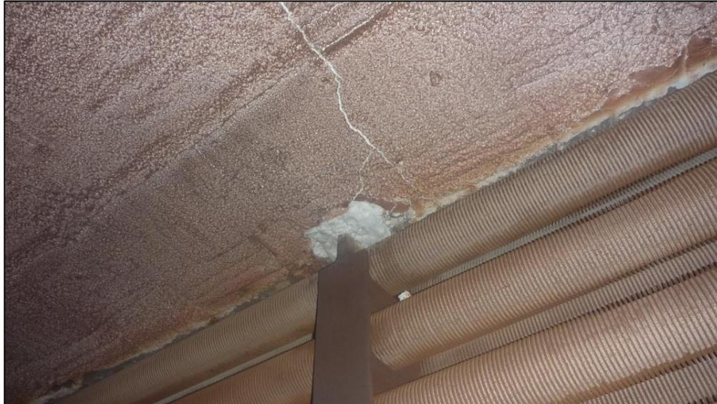
**Figura 4.36. Oxidación en placa tubular intermedia y relleno de fibra cerámica en orificio existente en el intercambiador E-4111. Fuente: Supermetanol, C.A**
