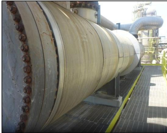
**Figura 4.22. Deterioro del sistema de protección del rehervidor E-4102, lado noreste. Fuente: Supermetanol, C.A**
