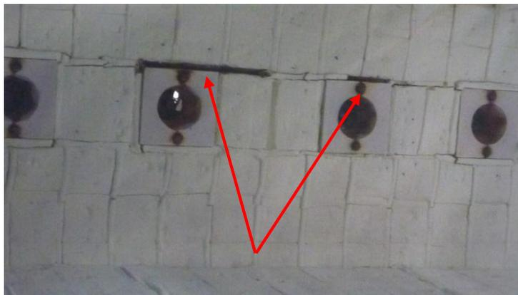
**Figura 4.8. Caída de cepas de fibra cerámica de quemadores. Fuente:**
