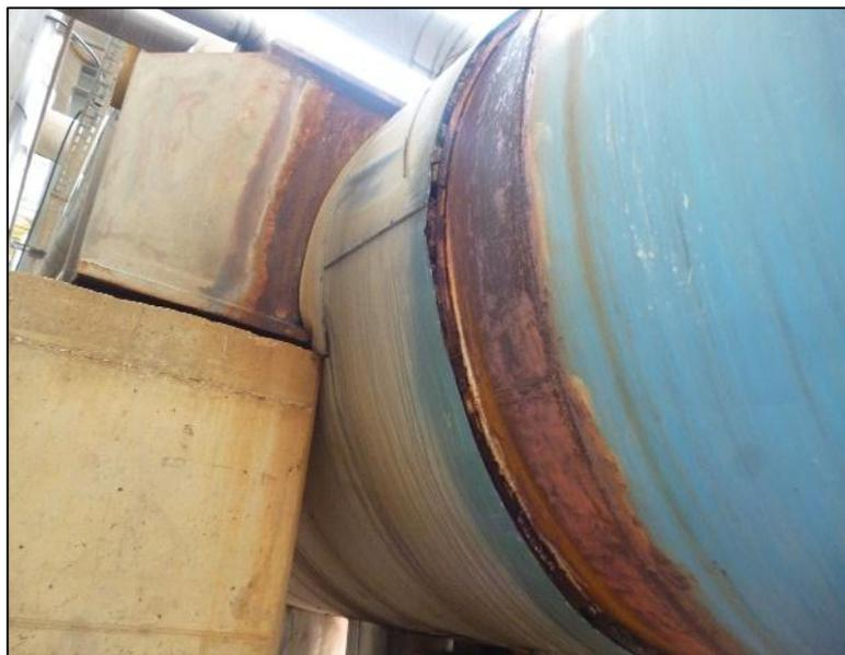
**Figura 4.31. Corrosión moderada generalizada por ausencia de pintura en el intercambiador E-4120B. Fuente: Supermetanol, C.A**
