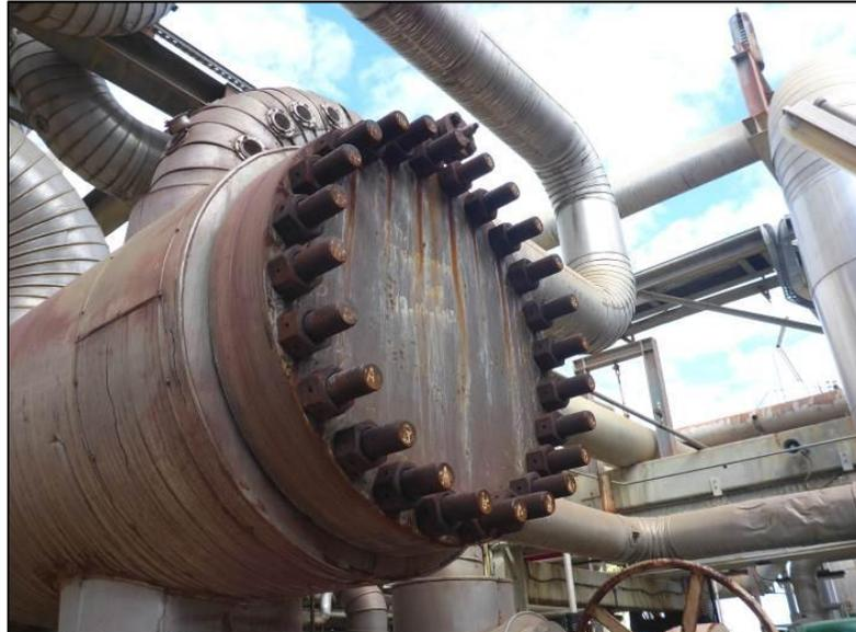
**Figura 4.15. Corrosión leve en tornillería asociada a la tapa este y deterioro en el sistema de aislamiento del E-4101B. Fuente: Supermetanol, C.A**
