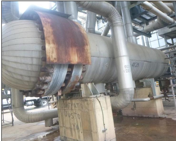
**Figura 4.33. Presencia de óxido en las láminas protectoras contra lluvia del atemperador E-4121. Fuente: Supermetanol, C.A**
