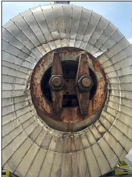
**Figura 4.38. Corrosión leve presente en el paso de hombre del cabezal lado Oeste del tambor V-4101. Fuente: Supermetanol, C.A**
