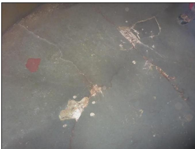
**Figura 4.42. Grietas y roturas de material refractario en piso. Fuente:
