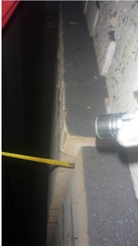
**Figura 4.12. Abombamiento de paredes de túneles zona inferior. Fuente: Supermetanol, C.A**
