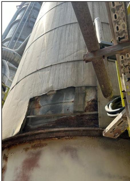
**Figura 4.40. Desprendimiento de sistema de aislamiento en tambor V-4103. Fuente: Supermetanol, C.A**
