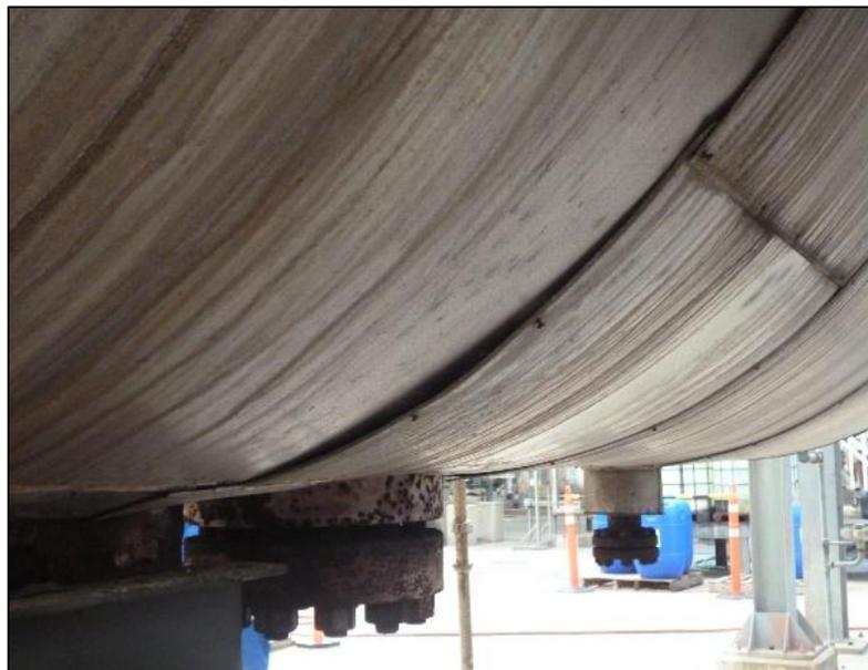
**Figura 4.28. Desprendimiento de chaqueta metálica de protección mecánica en zona localizada del E-4120A. Fuente: Supermetanol, C.A**
