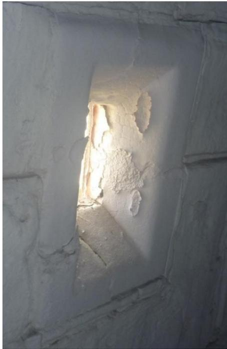
**Figura 4.9. Desprendimiento de material en mirilla superior lado norte.**
