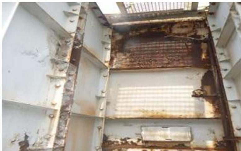
**Figura 4.4. Pared de la zona convectiva lado superior. Fuente: Supermetanol, C.A**
