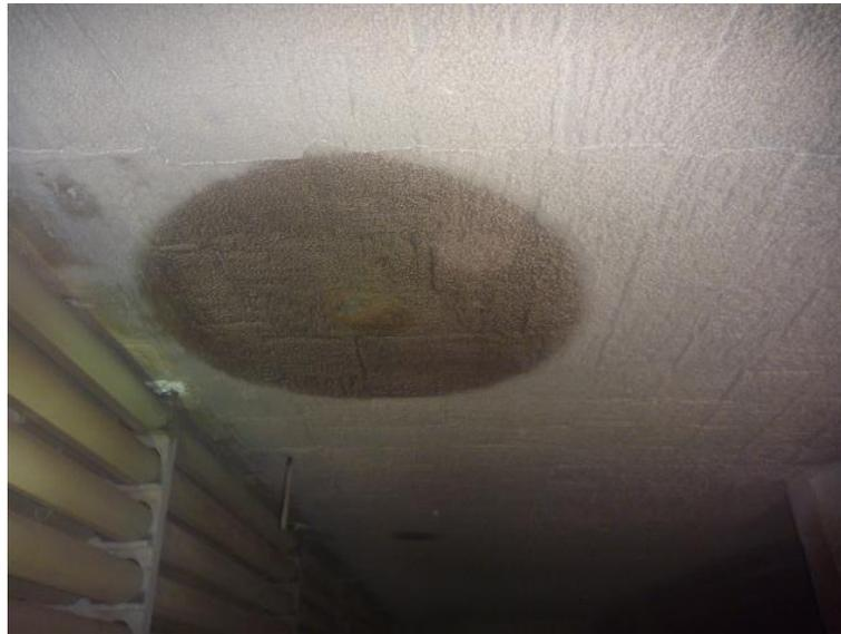
**Figura 4.21. Filtración presente en techo del E-4114. Fuente:**
