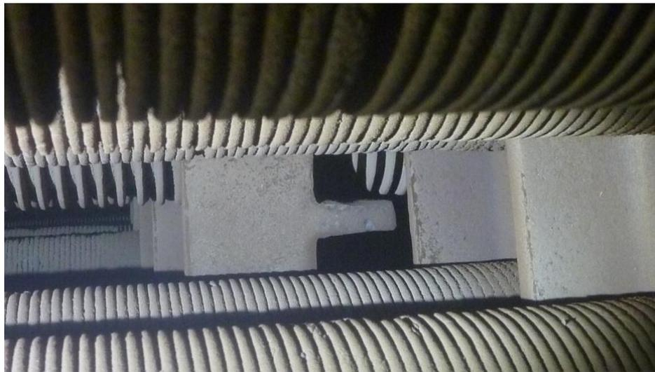
**Figura 4.18. Sedimentos presentes en tubos y placa tubular del E-4112C. Fuente: Supermetanol, C.A**
