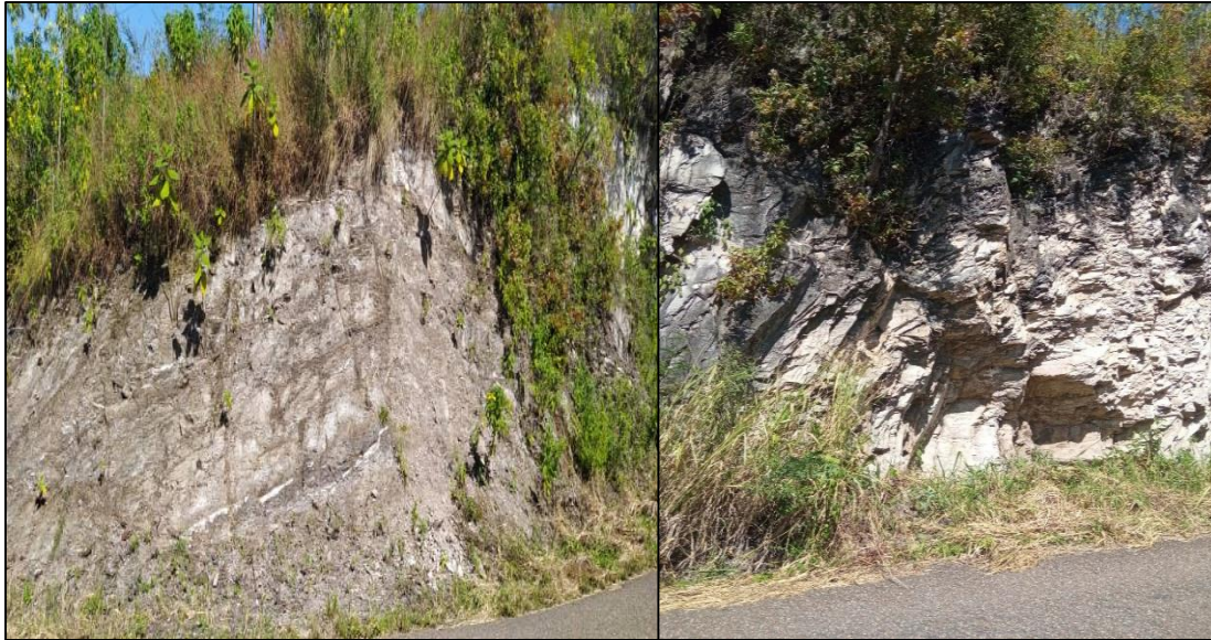
Figura 4.3 Talud N° 2, estación N° 2. Izquierda, sector Oeste del talud. Derecha sector este del talud
