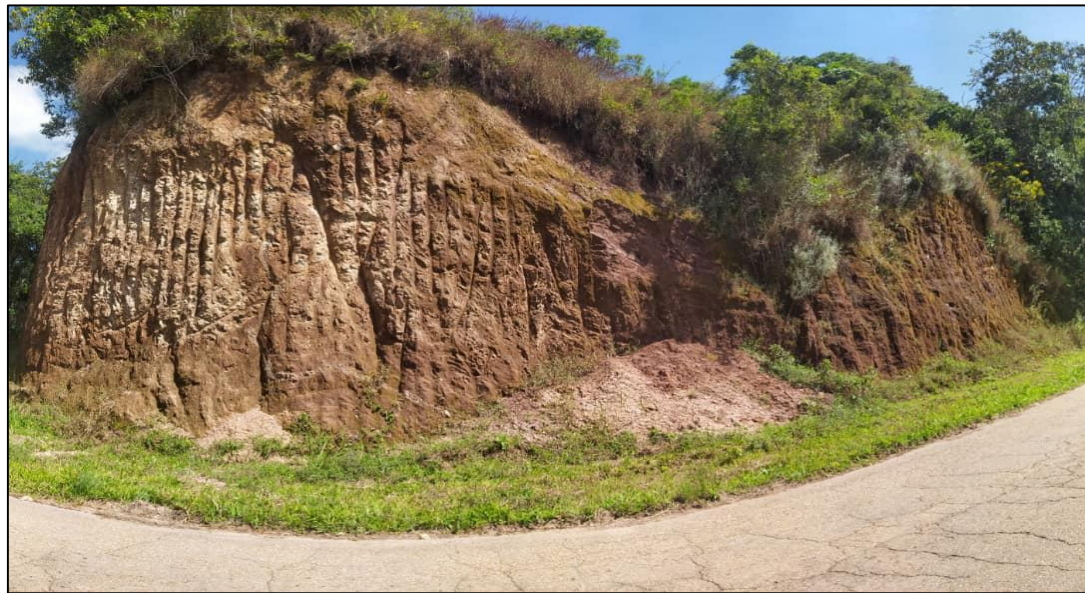
Figura 4.4 Talud N° 3, estación N° 3
