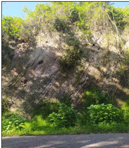
Figura 4.2 Talud N°1, estación 1, vista panorámica del talud
