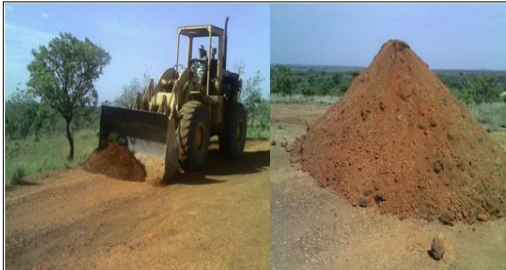
Figura 4.3 Recolección y apilamiento del material mediante maquinaria pesada.
